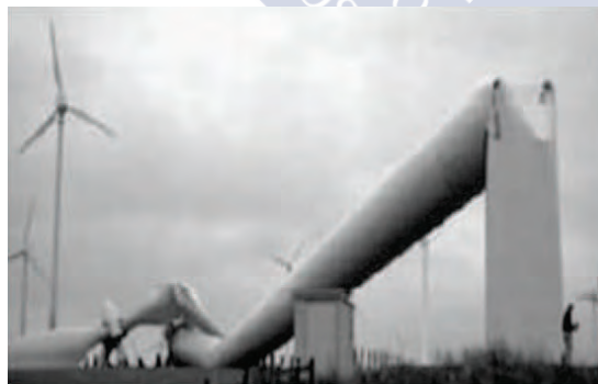
Figure B.1: Ejemplo de evento catastrófico: turbina eólica rota.
