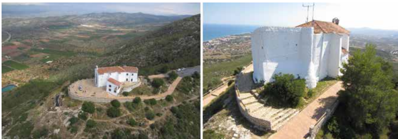
Figura 2. A la izquierda, vista general de la ermita de Santa Llúcia desde el este. A la derecha, vista desde el norte del conjunto, con el lienzo de muralla y torre medievales.
