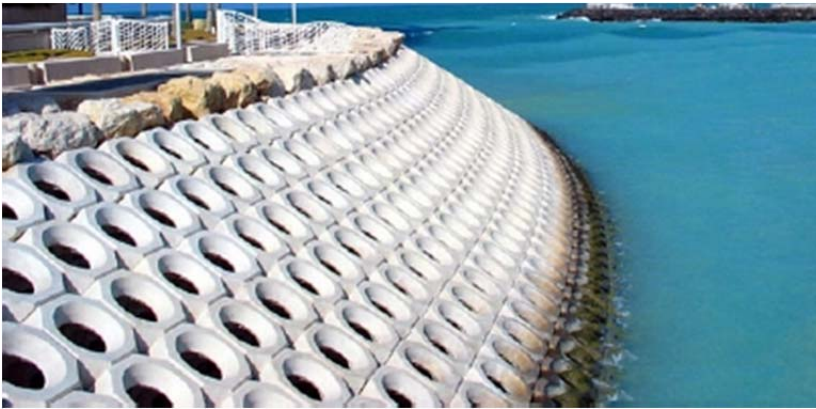
Figura 2- 17 Shed en un puerto en Dubái, fuente: Muttray & Reedijk (2009)
