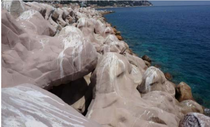
Figura 2- 16 Dique protegido con Ecopode, Idmer (2016)
