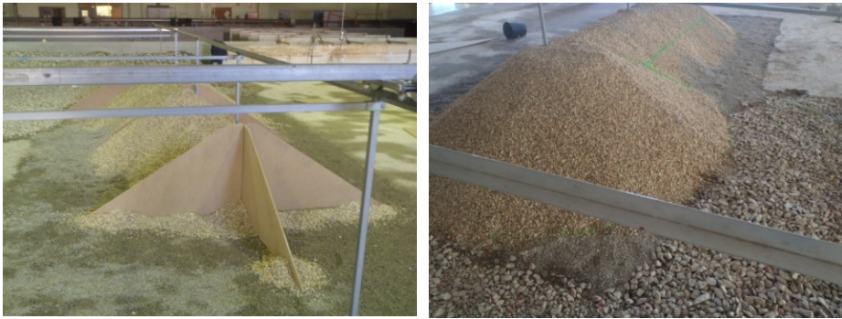
Figura 3- 14 Construcción del núcleo
