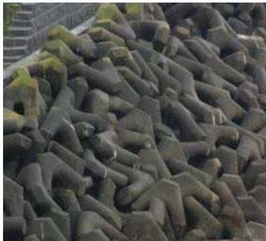
Figura 2- 7 Manto de protección del puerto de Soderick con Stabit
