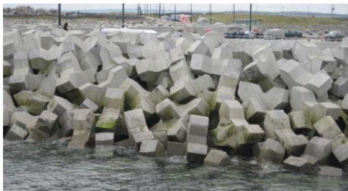
Figura 2- 15 Manto de protección del puerto de Caladh Mor, Irlanda en 2006, (Xbloc, 2016)
