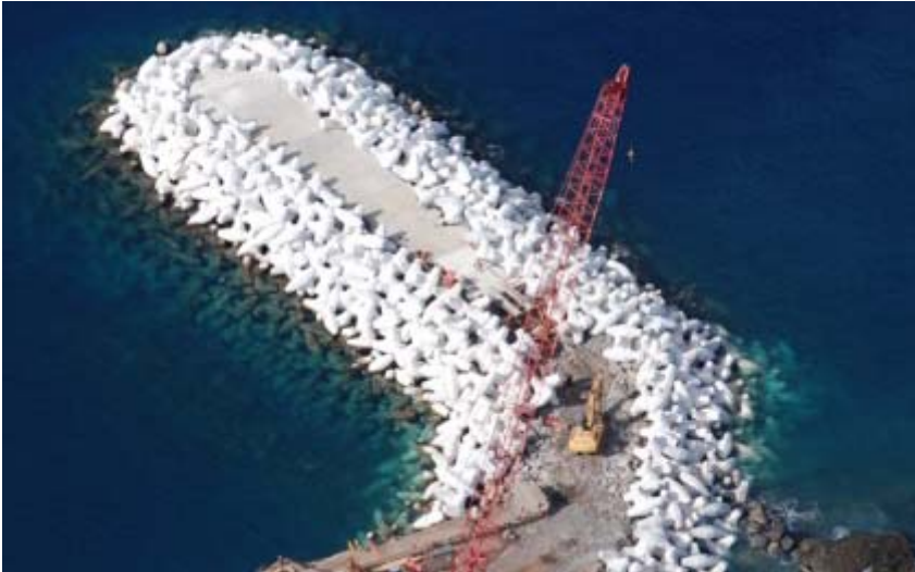
Figura 2- 13 reparación del dique Kaumalapau, Hawaii 2012, Baird (2016)
