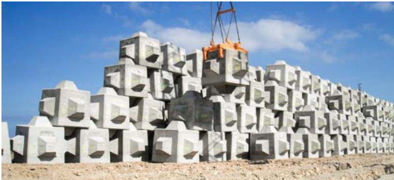
Figura 2- 21 Almacenamiento de cubípodos en la obra, Cubipod, (2016).
