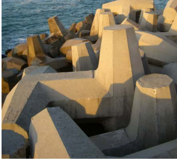
Figura 2- 8 Dolo en manto de protección bicapa
