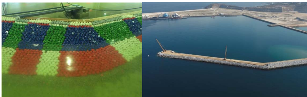
Figura 7. Tramo del quiebro monocapa de Cubípodos de W[t]=24 ensayado en el CITEEC tras H_s[m]=9.2>8.75 y vista aérea del Dique Oeste el 29/09/2015 (fuente: UTE Dique Oeste).
