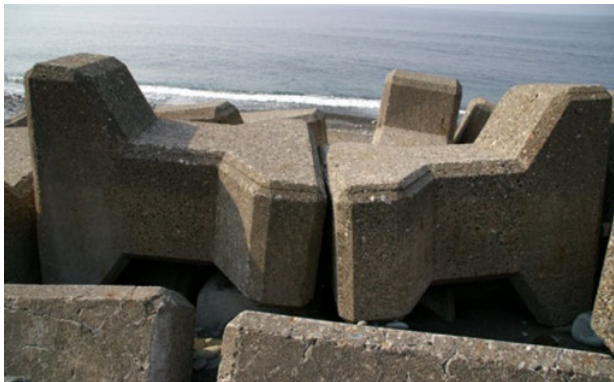
Figura 2- 3 Pieza Akmon en la coronación de un dique en talud
