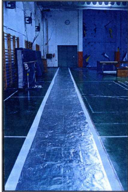
Fig. 15. Pasillo conductor realizado en aluminio.
