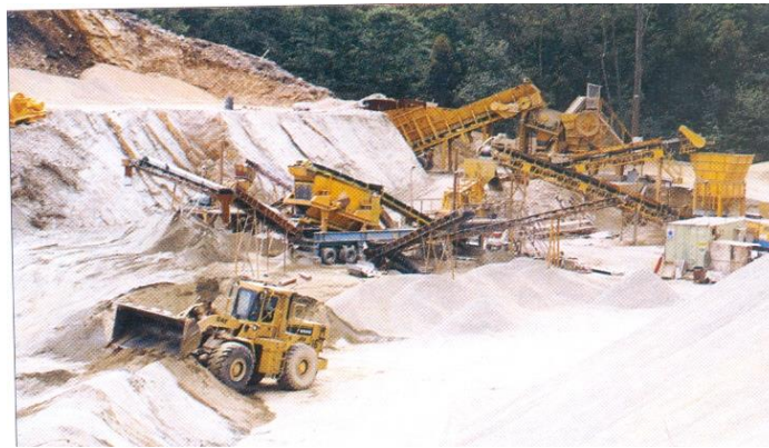
Planta de fabricación de áridos
