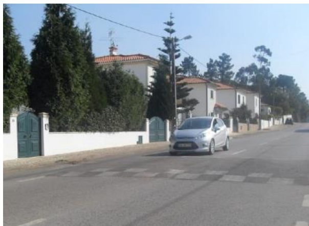
Figura 2.8 – Lomba alongada trapezoidal em Coimbra (Fonte: Silva, 2010)
