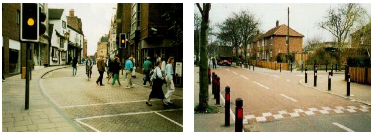
Figura 2.10 – a) Travessia pedonal elevada; b) Interseção elevada (BHTRANS, 2008)
