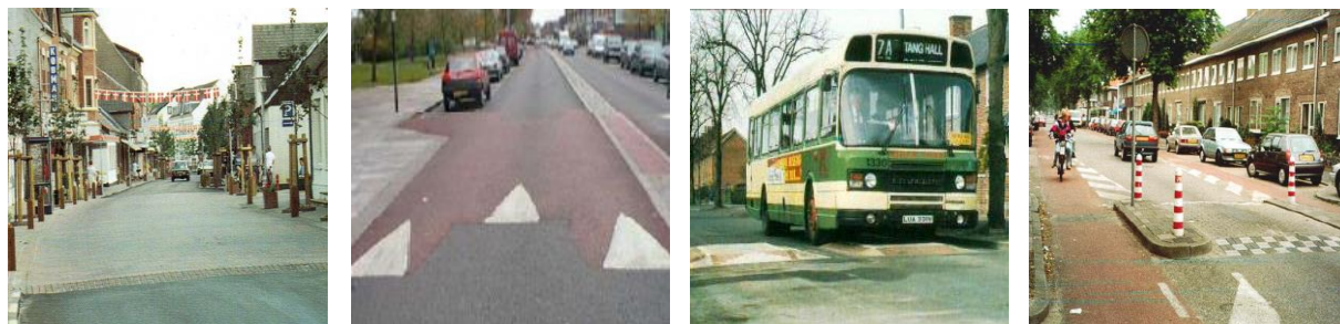
Figura 2.9 – Lomba: a) alongada (Esteves, 2003); b) combinada (InIR, 2011); c) "Speed Cushion" (BHTRANS, 2008); d) com canal destinado a ciclistas (Esteves, 2003)
