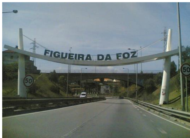
Figura 2.12 – Portão de entrada na Figueira da Foz (Silva, 2010)
