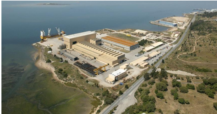
Figura 3.1 - Unidade industrial da GE em Setúbal (cedido pela GE).
