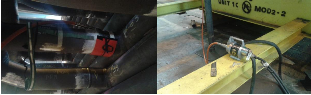
Figura 3.5 - Instrumentação da radiografia nos módulos do evaporador (cedido pela GE ).
