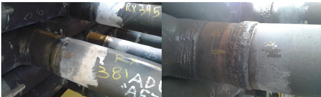
Figura 3.4 - Soldaduras topo a topo nos módulos para inspeção radiográfica (cedido pela GE).
