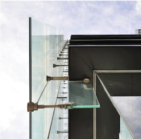
Fig. 160 Sobresaliente de la fachada respecto al límite del edificio
