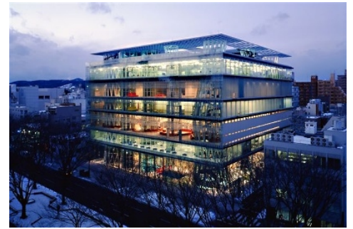
Fig. 125 Impacto nocturno del edificio – mayor visibilidad
