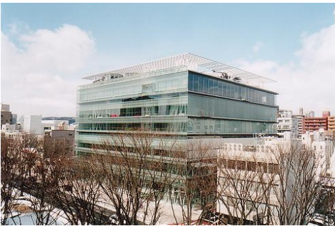
Fig. 122 Carácter simbólico edificio
