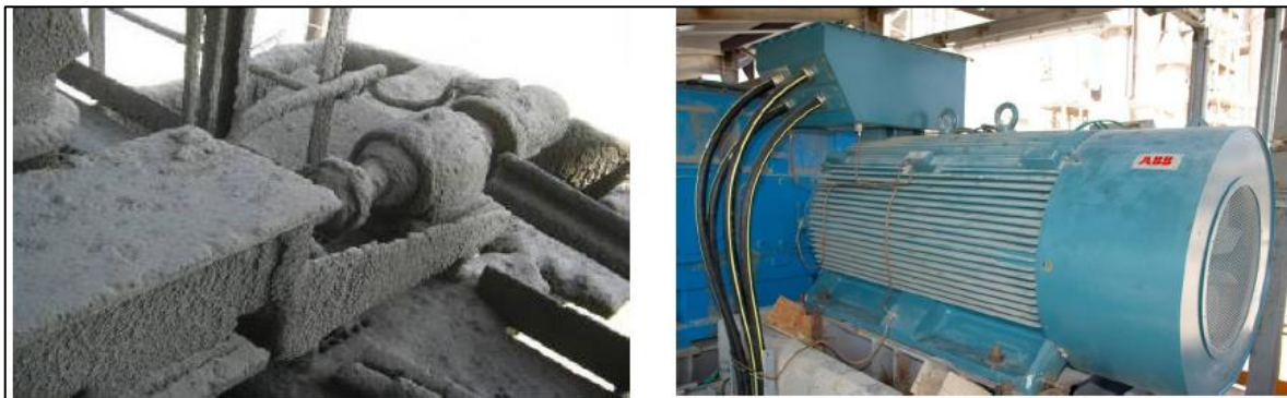
Figura 4.6. Mau exemplo (à esquerda) e bom exemplo (à direita) de limpeza
