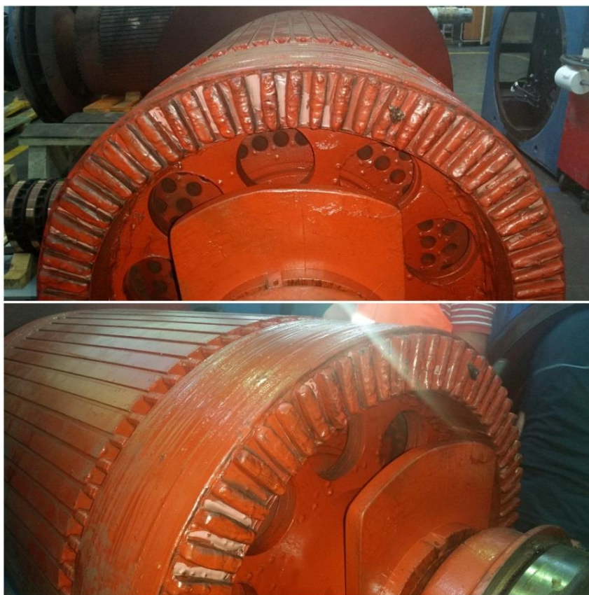
Figura A.10. Ventilação do rotor obstruída
