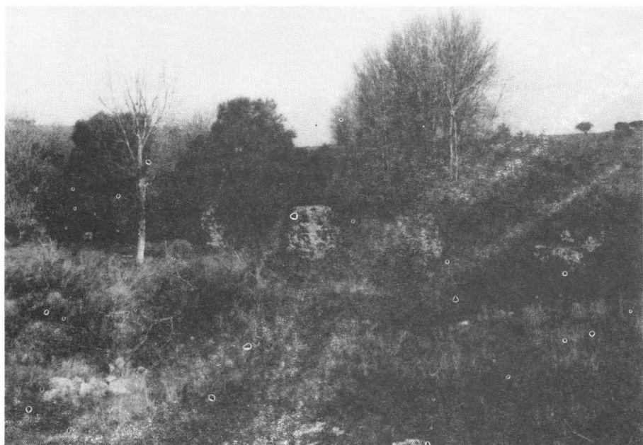
Fot. 4 — Barragem do Muro da Prega (Beja). Vista de jusante.
