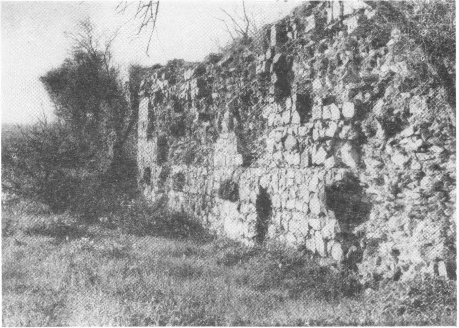
Fot. 5—Barragem de Pisões (Beja). Vista de jusante, com o revestimento exterior parcialmente conservado.
