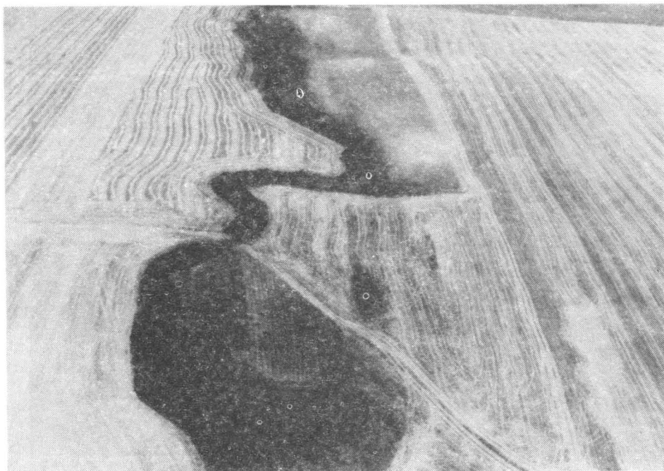
Fot. 3 — Barragem de Moralves (Elvas). Fotografia aérea oblíqua, de jusante. A linha de água desviou-se para a zona do encontro direito.
