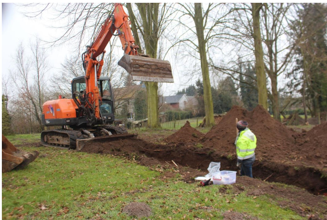
Figuur 109 Aanleg van sleuf 1
