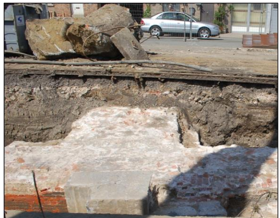
Fig. 54 De dwarsmuur in baksteen van het sluisgedeelte in werkput 1.
