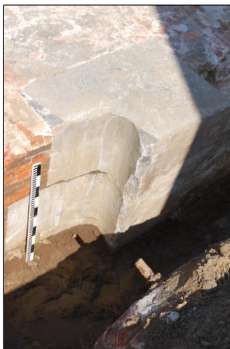
FIG. 53 De concaaf uitgewerkte hoekstenen in Petit Granit .
