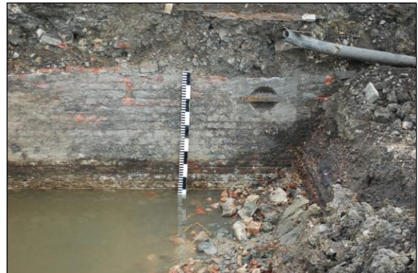
FIG. 48 Het aanmeerpunt of bolder in de kaaimuur van het kanaal.
