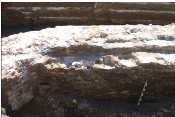
Fig. 55 De westelijke zijde van de sasmuur zonder paramentstenen.
