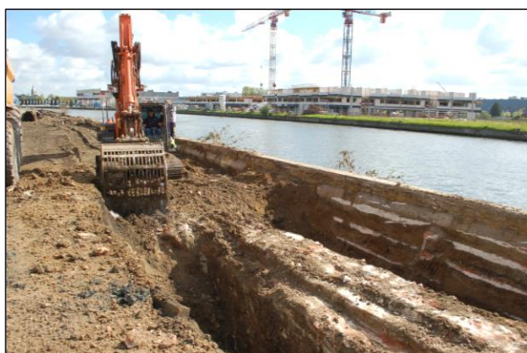
FIG. 39 Het uitgraven van de zuidelijke sluismuur.
