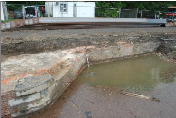
FIG. 47 Het noordelijk deel van het sluisgedeelte in werkput 2.
