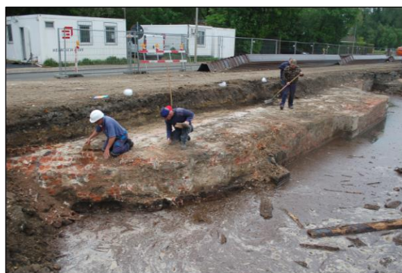
FIG. 40 Het opschonen van de noordelijke sluismuur.
