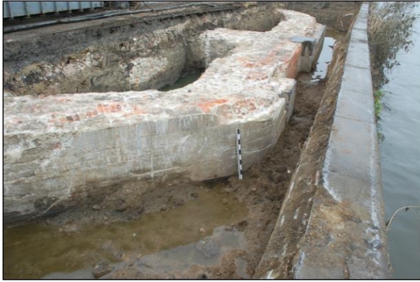
FIG. 49 Het zuidelijke deel van het sas in werkput 1.
