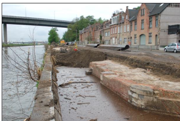
FIG. 42 Het noordelijk gedeelte van de sluis in werkput 2.
