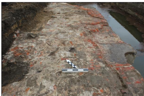
FIG. 44 De dwarsmuur in baksteen van het sluisgedeelte in werkput 2.
