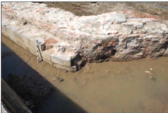
FIG. 51 Het noordelijk deel van het sas met ontmantelde muur in werkput 1.
