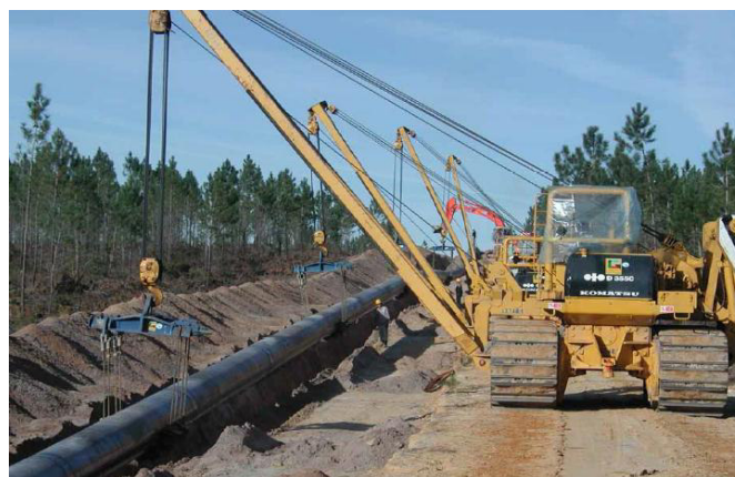
Figura 5.16 - Construção de gasoduto com colocação de tubagem em vala [Vasconcelos, 2011].
