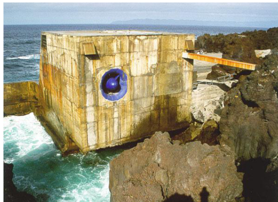
Figura 5.30 - Protótipo de aproveitamento da energia das ondas tipo coluna de água oscilante [PER, 2014c].
