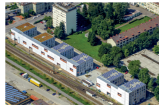
WOHNANLAGE: GUSTAV-SCHWAB-STRASSE KONSTANZ
