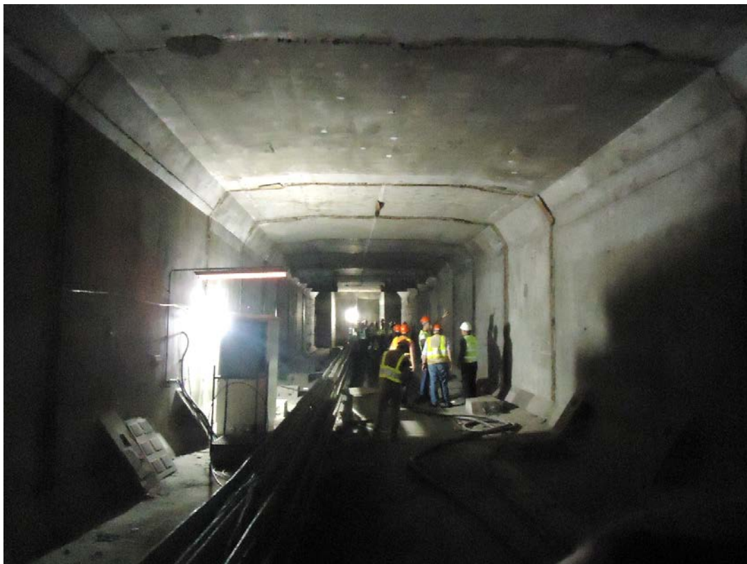
Bild 5: Betonhohlkasten (Foto: Daniel Achberger)
