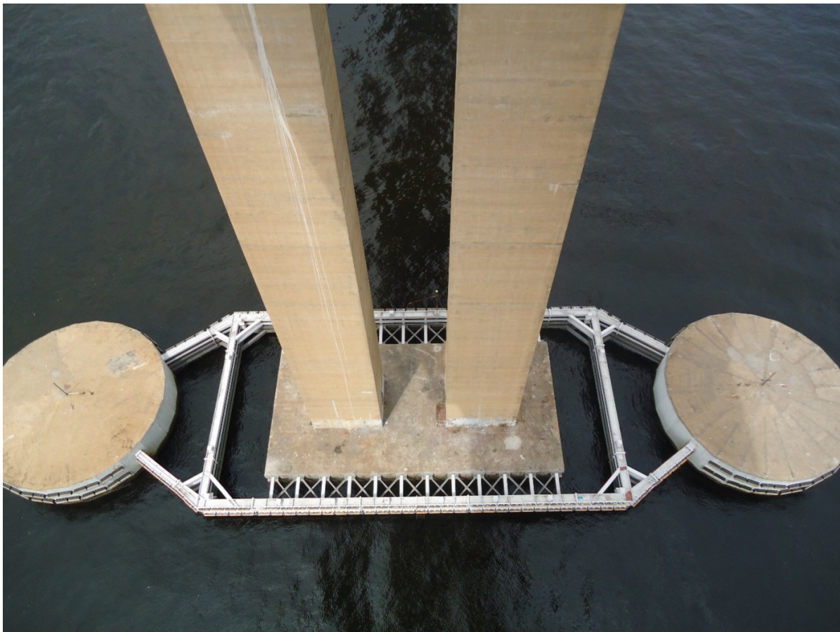
Bild 11: Erweiterte Fender an Brückenpfeiler (Foto: Daniel Achberger)
