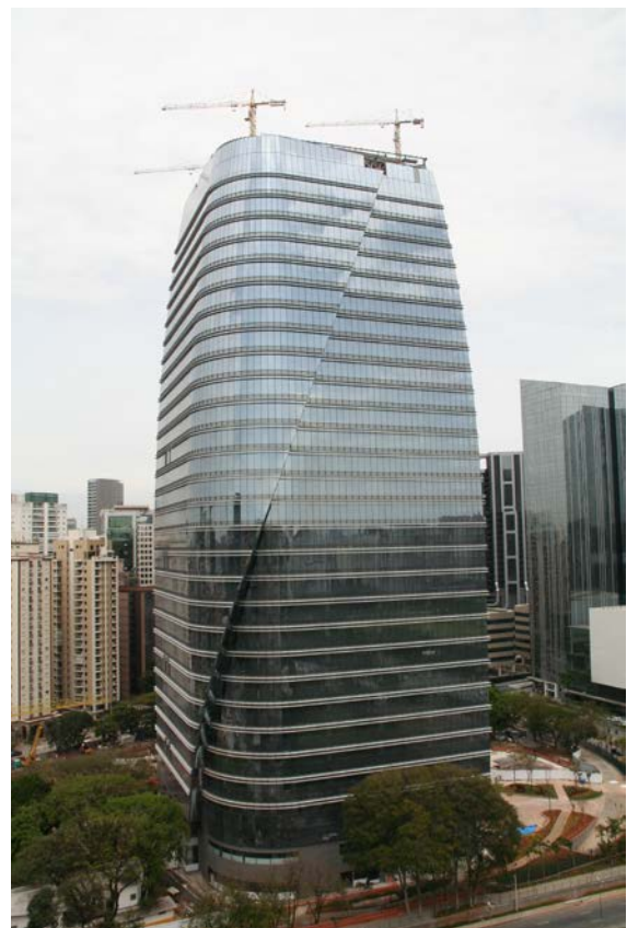
Bild 7: Neubau eines Bürogebäudes in Itaim Bibi (Foto: Horst Werkle)
