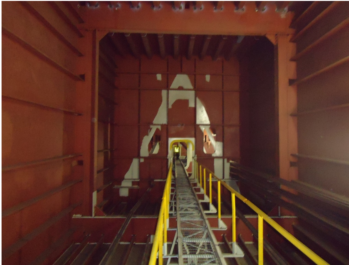
Bild 7: Querschott im Stahlhohlkasten (Foto: Daniel Achberger)
