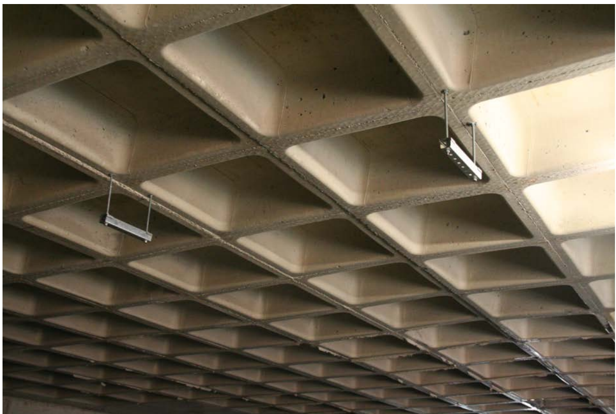
Bild 15: Kassettendecke (Foto: Horst Werkle)
