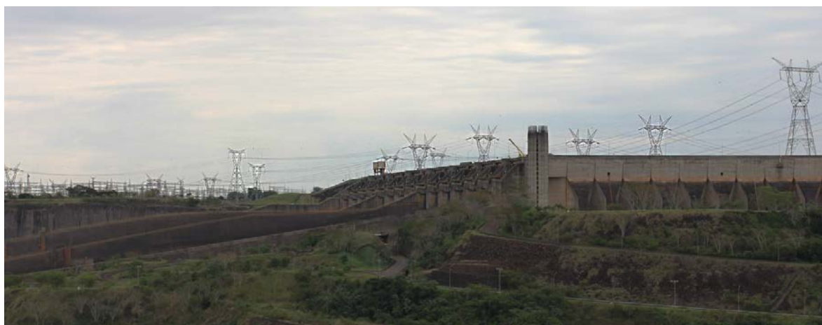
Bild 5: Freileitungen und Entlastungsbauwerk (Foto: Anna Belsch)
