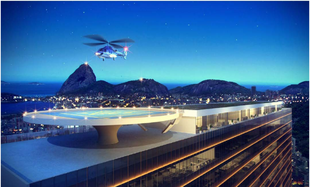
Bild 19: Helikopterlandeplatz (Heliport) auf dem Dach des REC Sapucaí [2]
