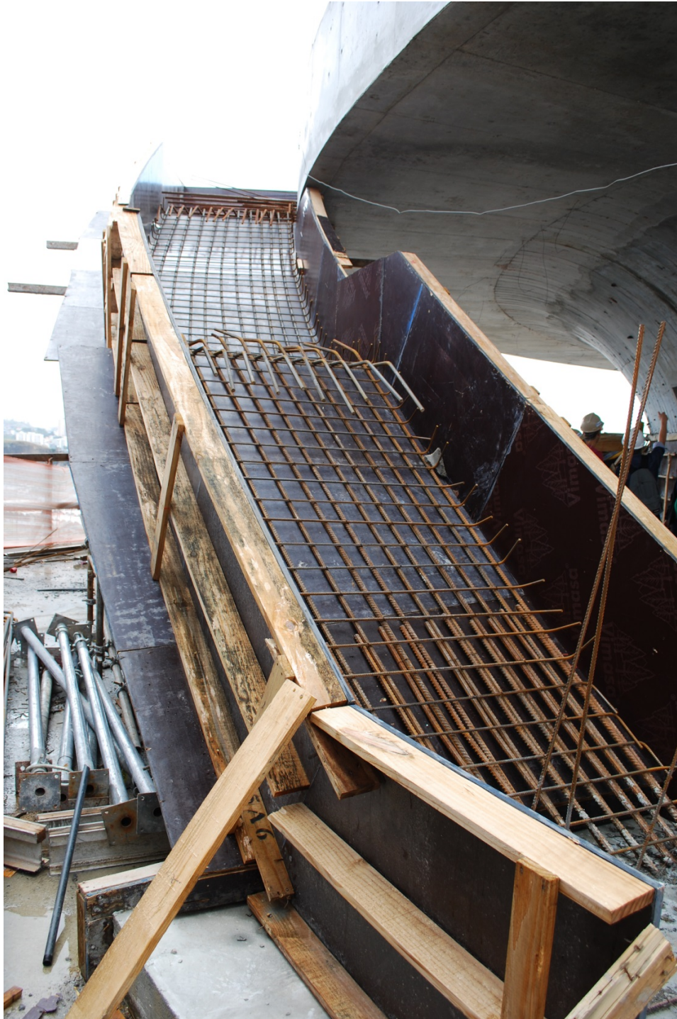
Bild 24: Aufgang zum Heliport in Ortbetonschalung (Foto: Samuel Haller)
