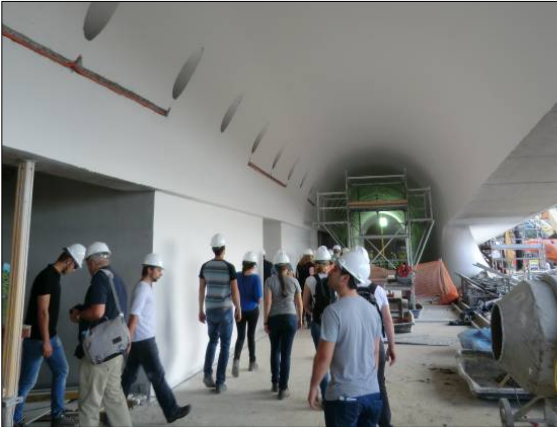
Bild 11: Seitliche Gewölbegänge ausgeschalt (Foto: Stefan Auer)
