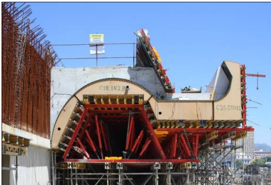
Bild 10: Schalung der seitlichen Gewölbegänge (Foto: PERI)
