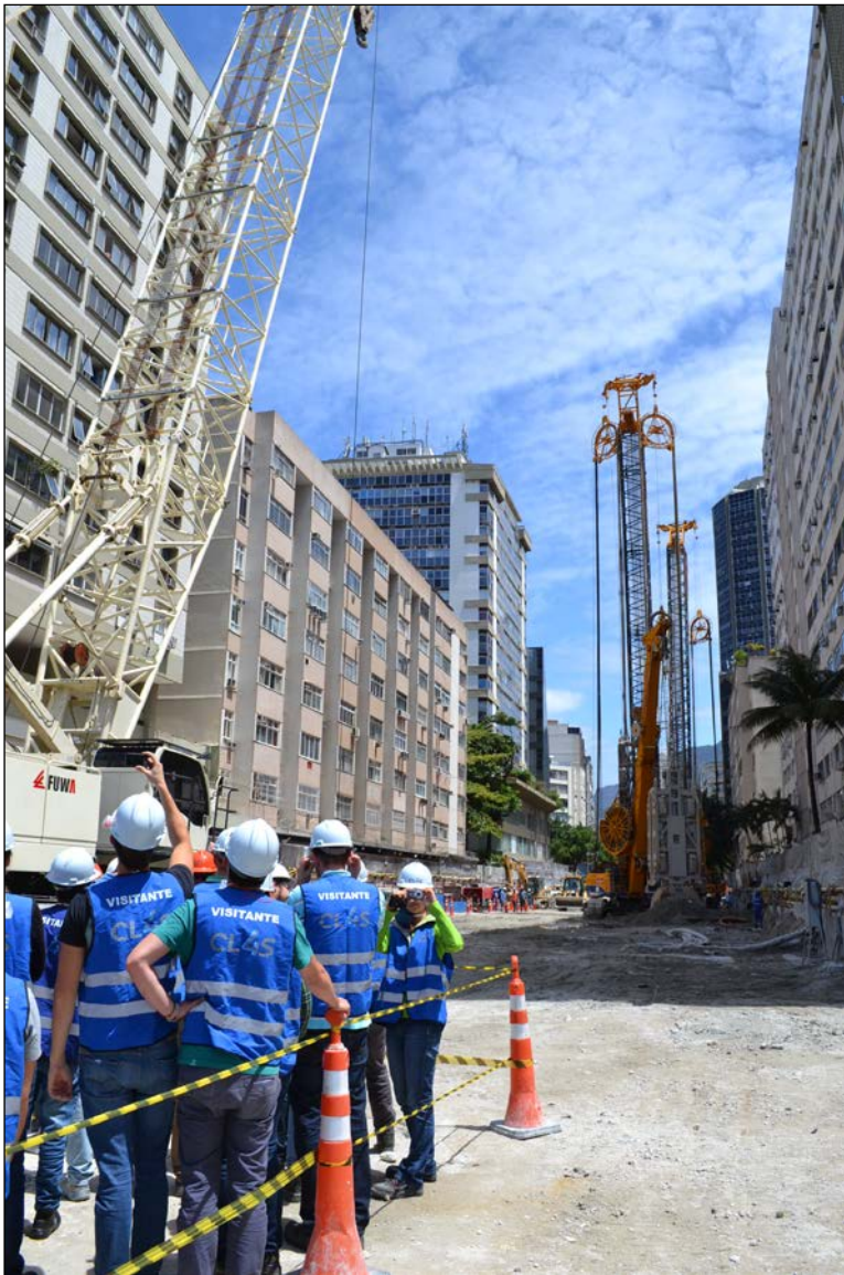
Bild 9: Baustelle JAL (Foto: Raphael Holzer)
