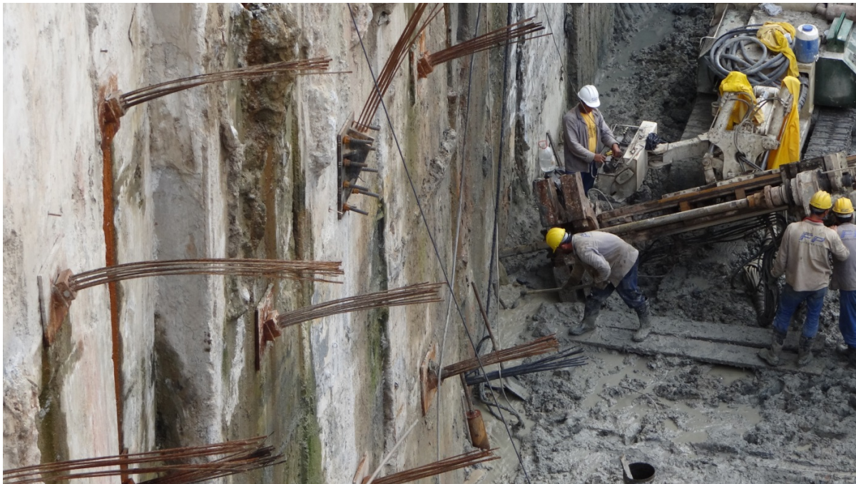
Bild 37: Rückverankerung (Foto Peter Hirschmann)
