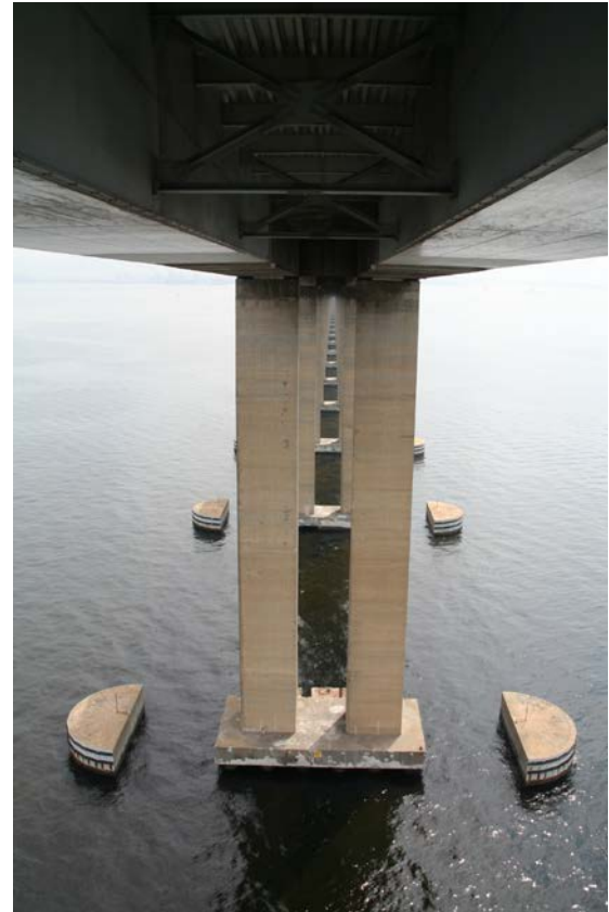
Bild 4: Untersicht Stahlhohlkasten (Foto: Horst Werkle)
