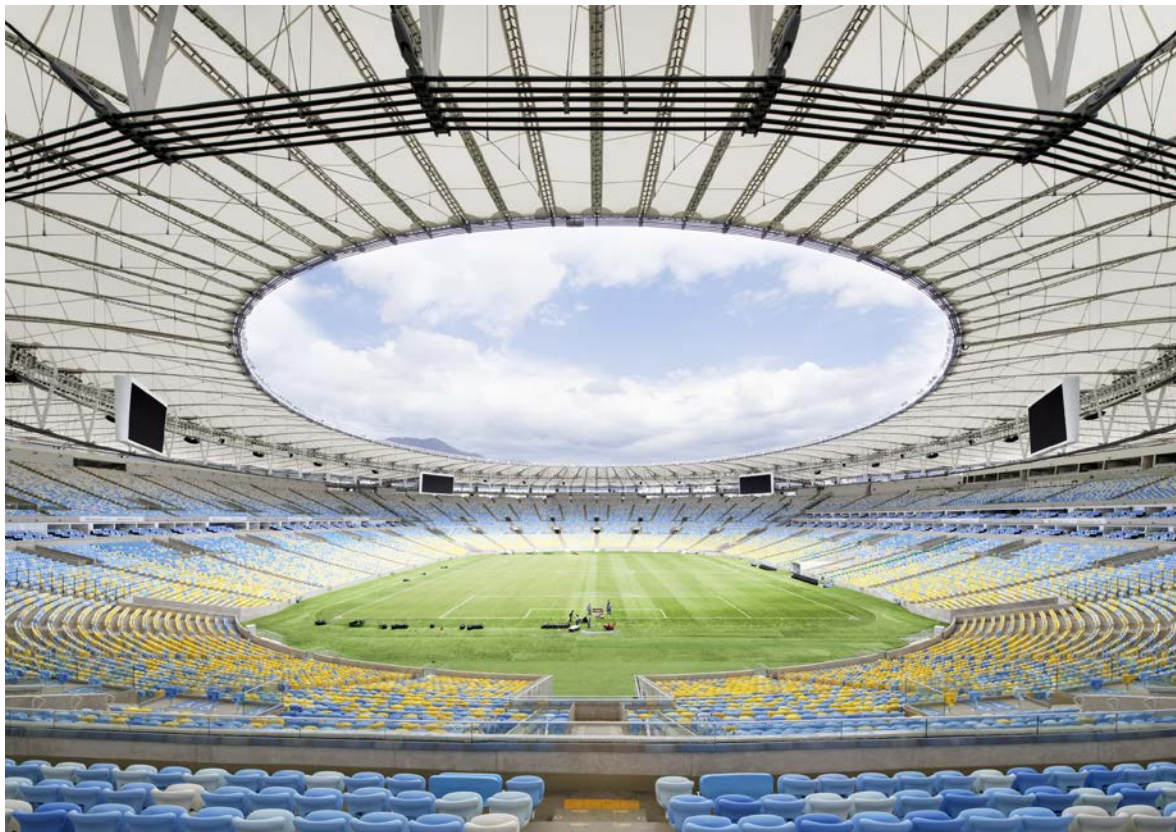
Bild 11: Für den Zuschauer erweckt das neue filigrane Speichenraddach den Eindruck als würde es über der Tribüne schweben (Foto: schlaich bergemann und partner, Markus Bredt)
