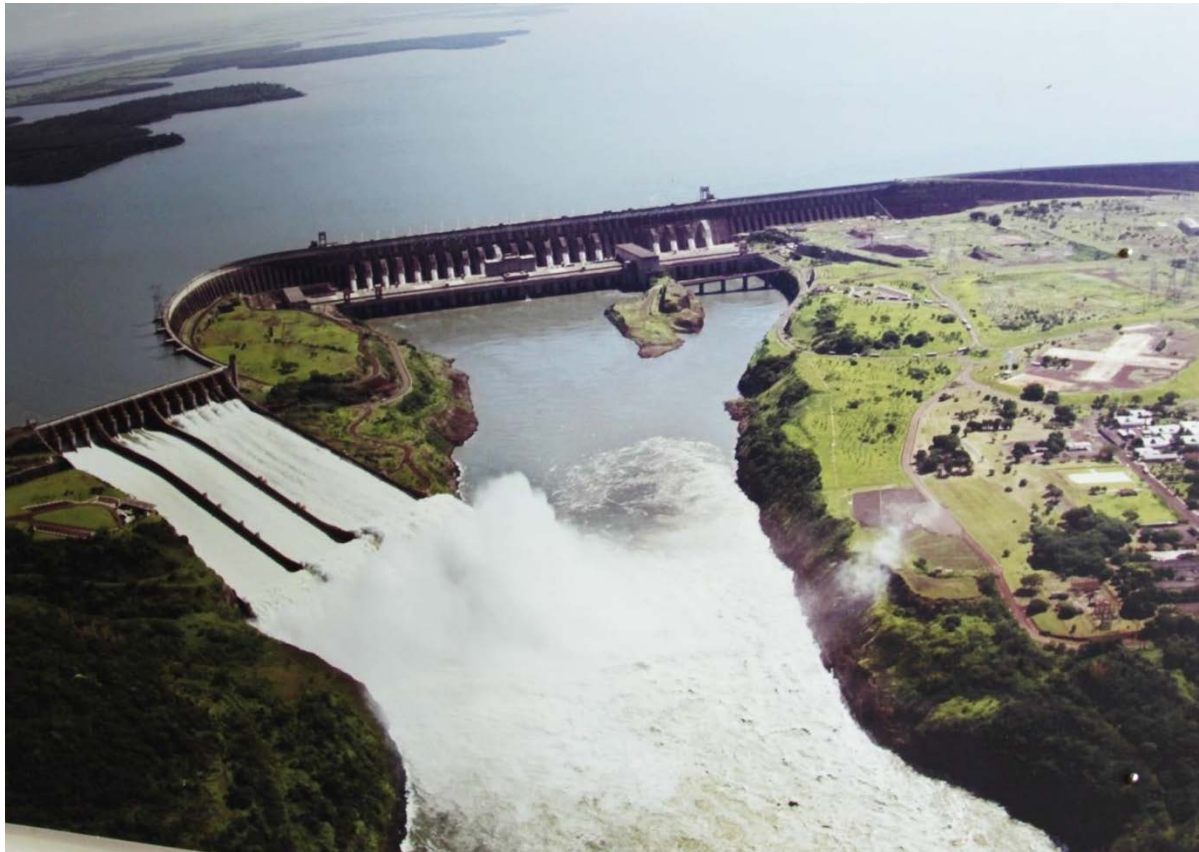
Bild 3: Hochwasserentlastungsbauwerk in Betrieb (Archivbild)
