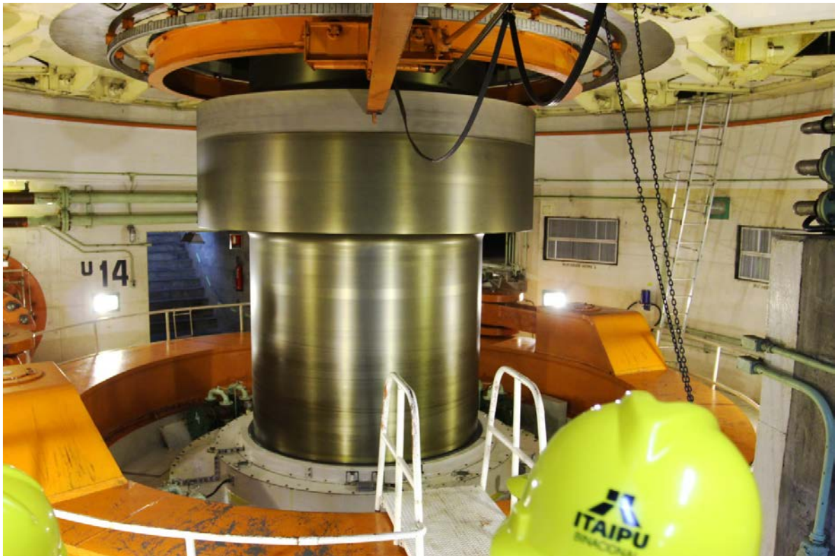
Bild 7: Eine Turbinenwelle des Wasserkraftwerks (Foto: Anna Belsch)
