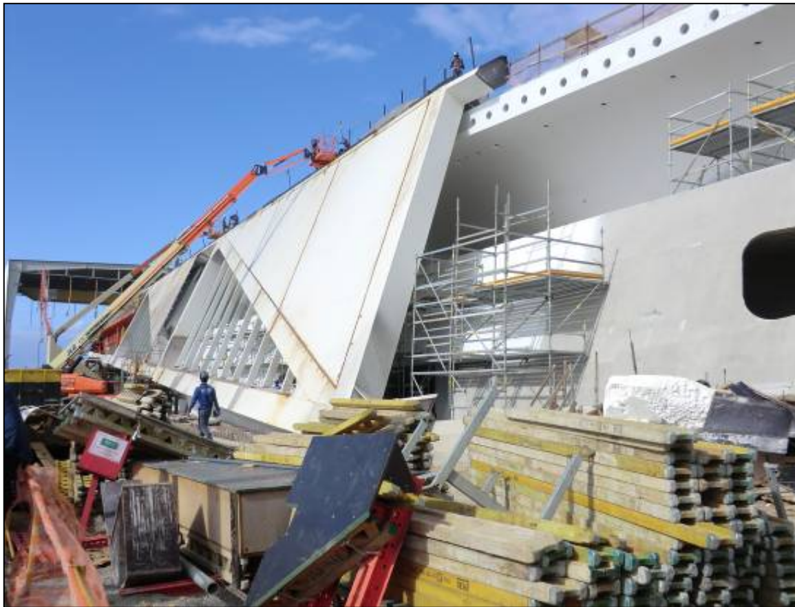
Bild 7: Montage der seitlichen Stahlflügel (Foto: Stefan Auer)
