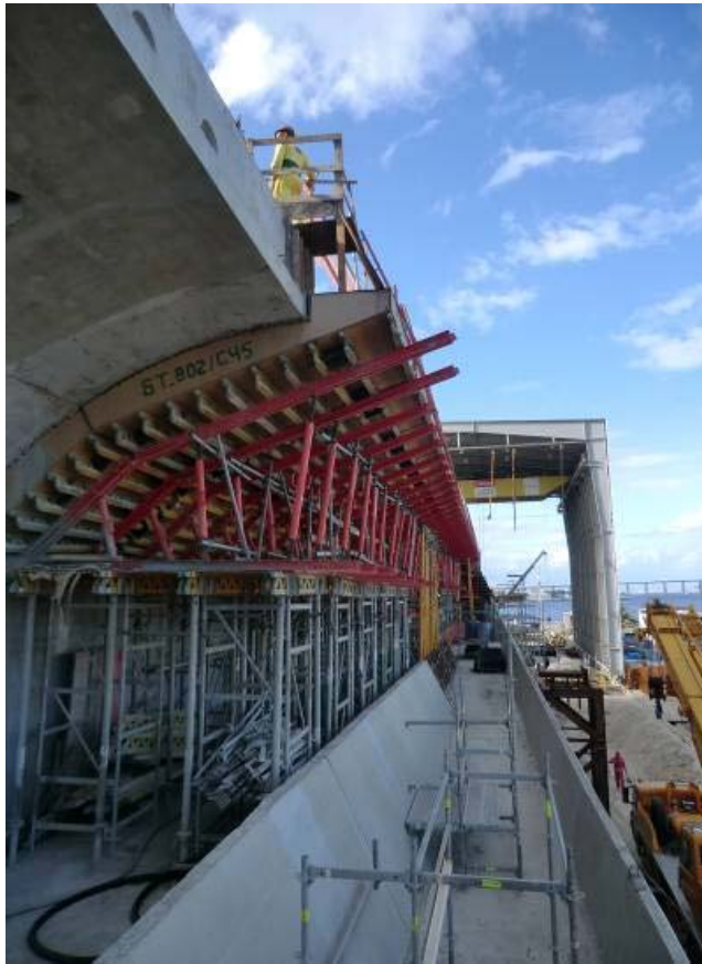
Bild 9: gekrümmte Schalelemente im Dachbereich (Foto: Stefan Auer)
