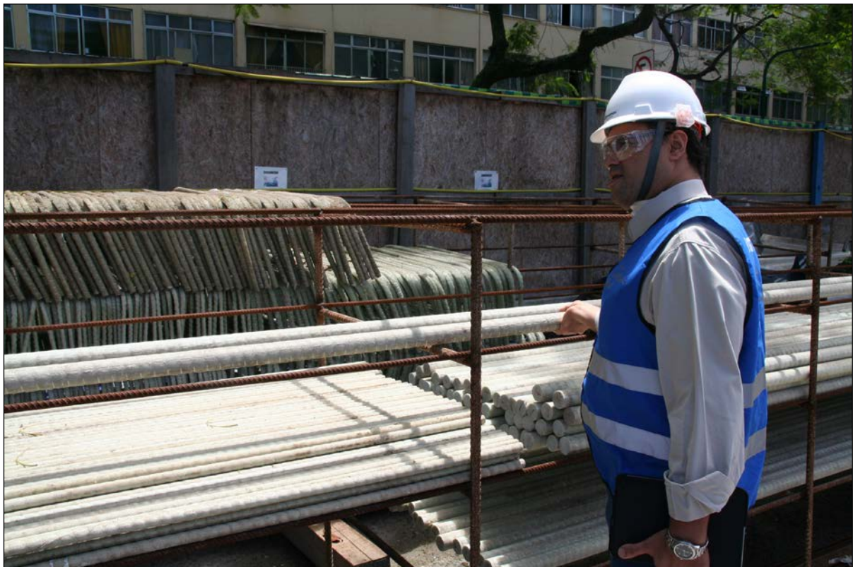
Bild 7: Herr Sebastião Silveira erklärt den Einsatz der Bewehrungsstäbe aus Glasfasern (Foto: Horst Werkle)
