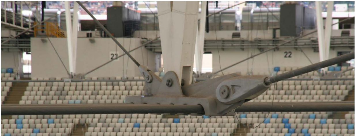
Bild 8: Unteres Anschlussdetail der Luftstütze (Foto: Horst Werkle)
