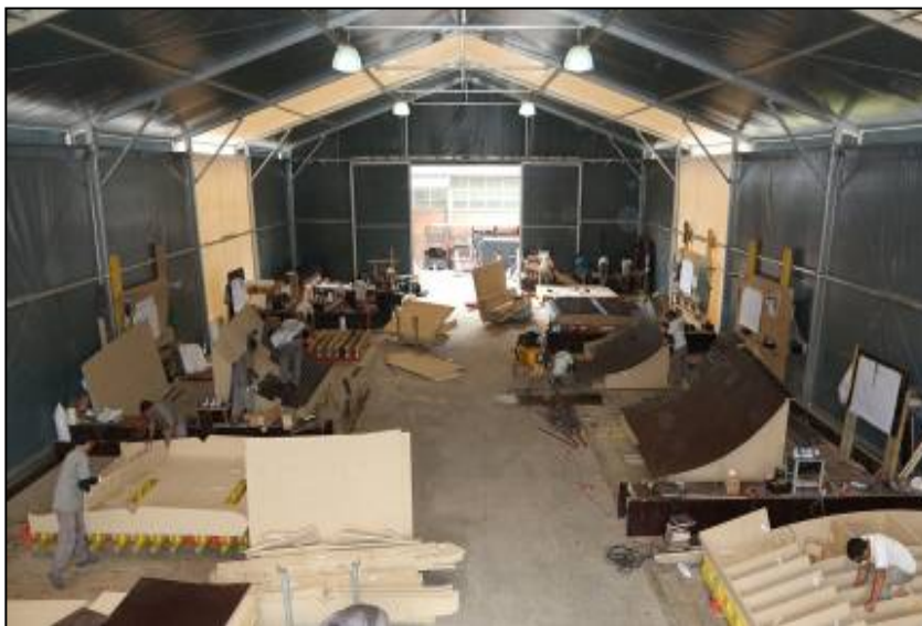
Bild 12: Vormontage in Sao Paulo (Foto: PERI)
