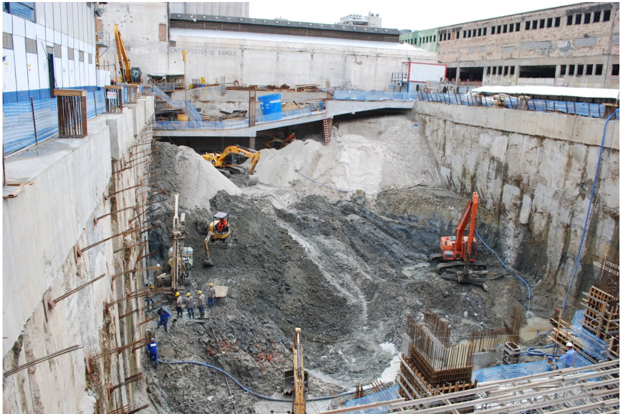
Bild 34: Baugrube (Foto Samuel Haller)
