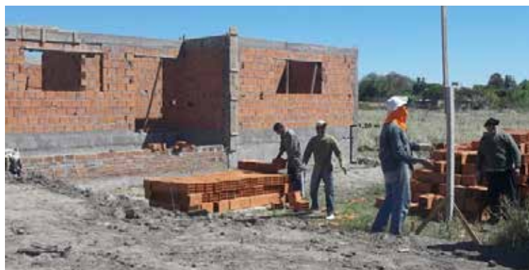
Figura 8. Construcción de una vivienda sobre un paisaje de bañados secos
