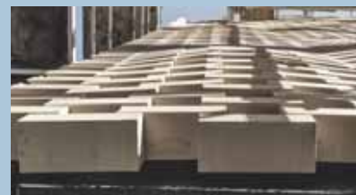
Fase di montaggio in cantiere.
