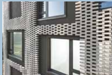
Vista del rapporto tra rivestimento e aperture.
