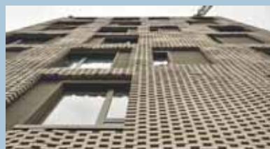
Vista del rapporto tra rivestimento e aperture.
