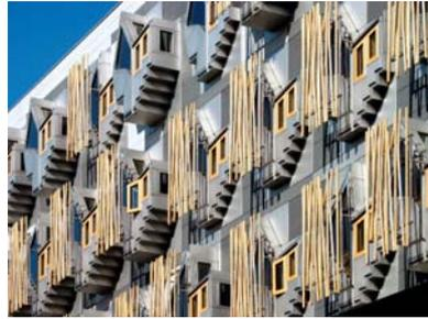
**Fig. 5** Enric Miralles, Benedetta Tagliabue - EMBT, Nuovo Parlamento Scozzese di Edimburgo. Le schermature sono discontinue e costituite da un insieme di elementi tubolari in quercia con passo variabile
