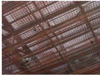
**Fig. 8** Herzog & De Meuron. Una seconda pelle interna in lastre di rame microforate funge da filtro per la luce. A parità di foratura (vuoto su pieno) la dimensione del foro e il materiale possono incidere sulla prestazione
