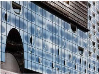
**Fig. 7** Elbphilharmonie di Amburgo, Hergoz & De Meuron. Il vetro è serigrafato e curvato. Le aperture che si generano in corrispondenza della curvatura, implementano il grado di complessità nel calcolo della prestazione
