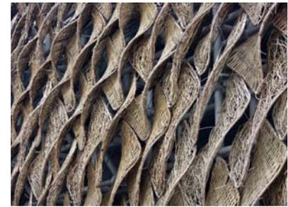
**Fig. 9** Padiglione Spagnolo per Expo Shanghai 2010, Enric Miralles, Benedetta Tagliabue - EMBT. In questo progetto la complessità della schermatura solare è evidente: differenti forme anche a doppia curvatura, elementi con differenti giaciture, diverso rapporto vuoto su pieno e differenti forme di campitura
