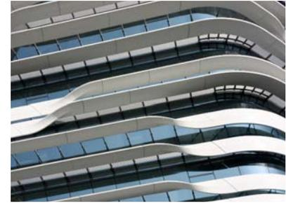
**Fig. 6** Zaha Hadid. Le schermature solari sono costituite da elementi orizzontali in parte a ridosso della superficie vetrata e in parte vincolate alla struttura di facciata ma in aggetto. La variazione di posizionamento e la variazione di forma generano, a parità di orientamento, una variazione di apporti solari gratuiti
