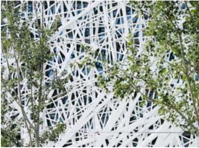
**Fig. 4** Palazzo Italia EXPO2015. La seconda pelle in calcestruzzo armato. Ogni pannello è diverso dall'altro per forma e per rapporto di vuoto su pieno (% foratura). Questo è stato possibile grazie alla perfezione e al grado di precisione ottenibile impiegando il cemento biodinamico, unitamente all'impiego di strumenti di progettazione parametrica
