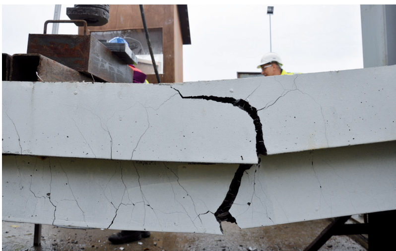
Foto in alto: deformazione flessionale sotto carico di 120 kN
