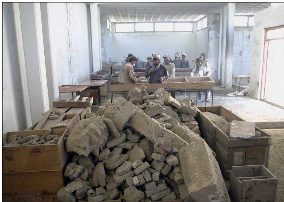
Fig. 3 – Ripresa dei lavori nei magazzini, MAIA 2002.
