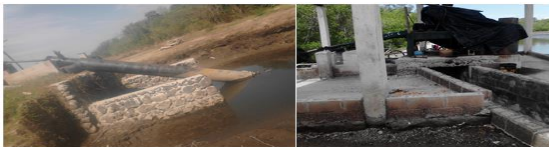
FIGURA 4. (DERECHA) SISTEMA DE BOMBEO EL TORNO. (IZQUIERDA) SISTEMA DE BOMBEO SENDEROS DE PAZ
