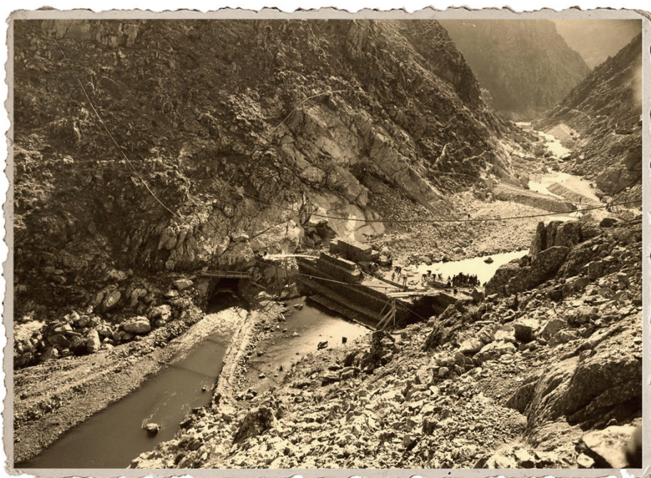
Inizio dei lavori dello sbarramento sul Flumendosa. Fonte [107]
