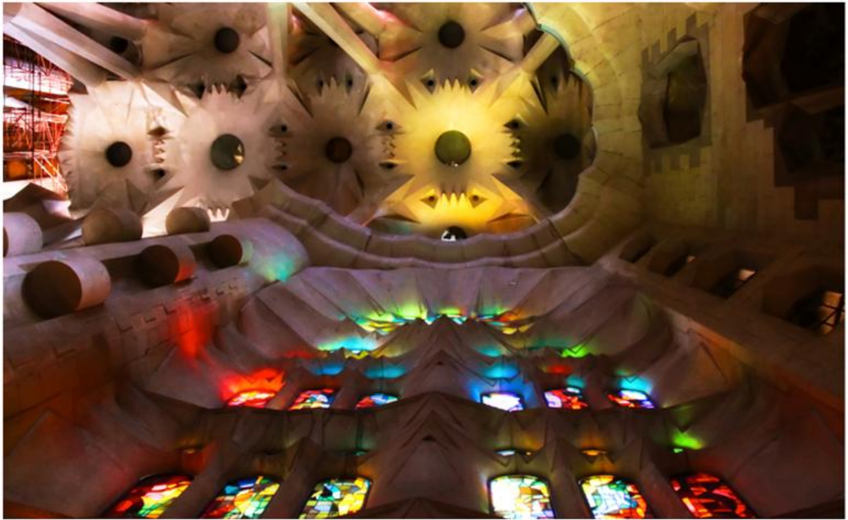
Fig. 1 Hyperboloid vault of the Sagrada Família.
