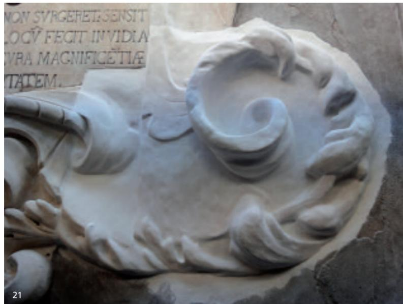
**Fig. 21** Integrazione materica della voluta mancante secondo la tecnica dell'astrazione volumetrica.
