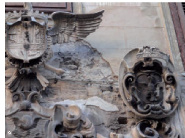
teriale carbonatico, di ossidi di ferro dovuti alla corrosione dei perni di ancoraggio dei vari elementi scultorei.
