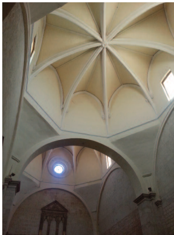
2. Andria. Chiesa di Santa Maria di Porta Santa, coperture.
