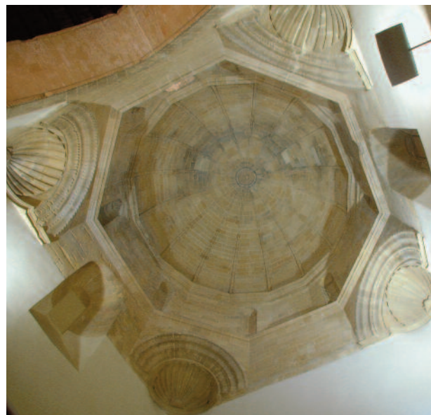
9. Mazara del Vallo. Chiesa di Sant'Egidio, cupola.
