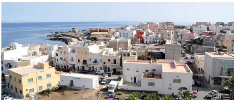
Figura 62. Pantelleria Capoluogo (palazzetti con tetti piani)
