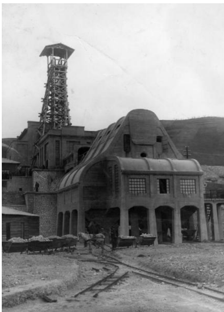
Grottafalda. Veduta del pozzo Mezzena con il castello di estrazione e il silos di raccolta del minerale.
