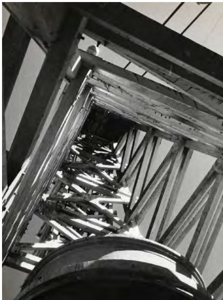
Grottafaldina. Pozzo Mezzena: veduta dal basso e dall'interno del castello di estrazione.
