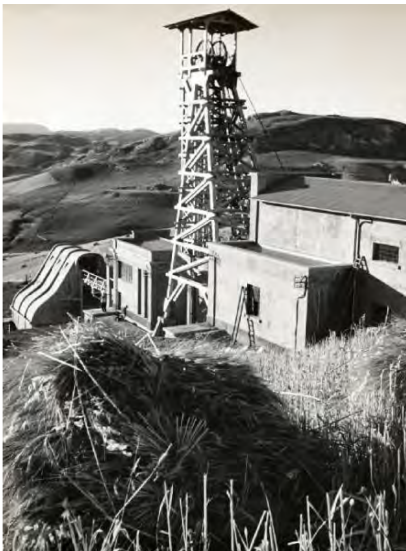
Grottafaldina. Veduta del pozzo Mezzena con il castello di estrazione e il silos di raccolta del minerale.
