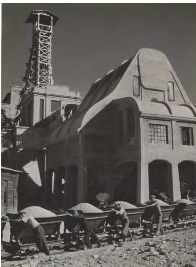
Grottafaldina. Veduta del pozzo Mezzena con il castello di estrazione e gli operai con carrelli che spostano il minerale estratto.
