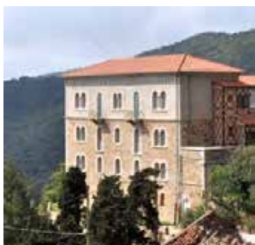
Il palazzo degli uffici della miniera di Ingurto ad Arbus, Sardegna
