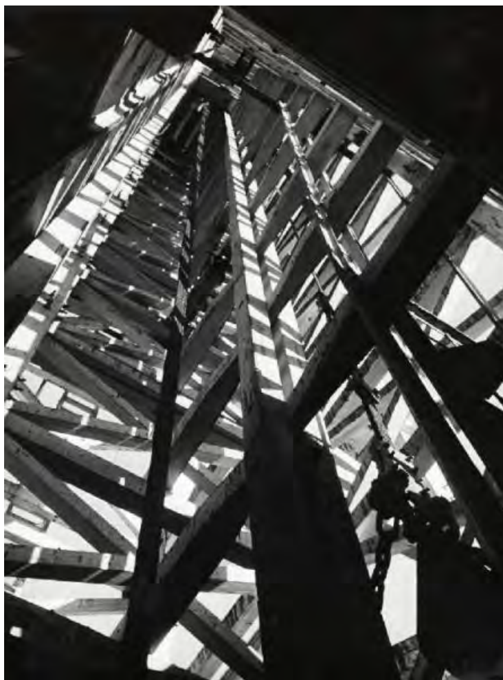
Grottacalda. Pozzo Mezzena: veduta dal basso e dall'interno del castello di estrazione.
