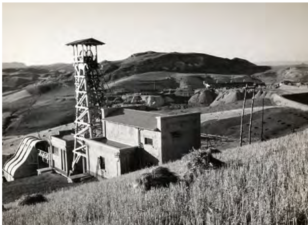
Grottafaldina. Veduta del pozzo Mezzena con il castello di estrazione e il silos di raccolta del minerale.
