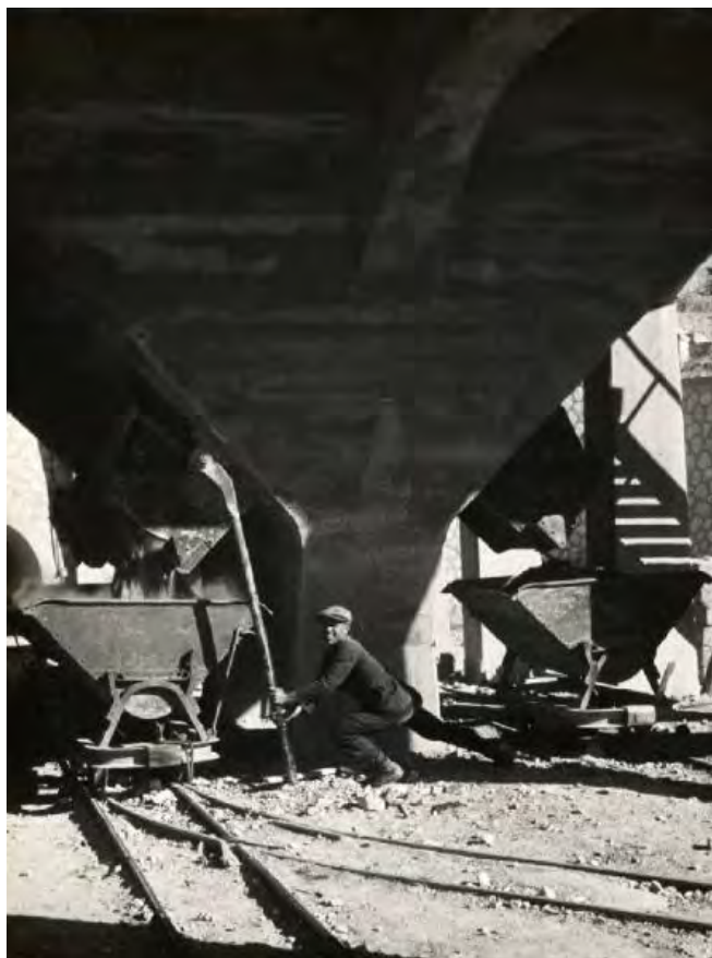
Grottacalda. Silos di raccolta del minerale estratto dal pozzo Mezzena: un operaio carica un vagone.
