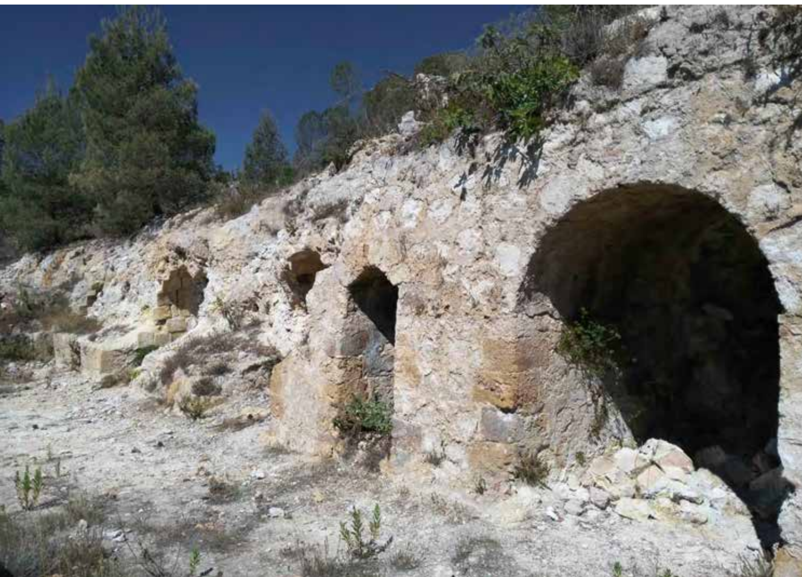
Ruderi dei Forni Gill. Foto dell'autore.
