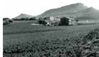
Caltanissetta, il quartiere Santa Barbara durante il cantiere per la sua costruzione
