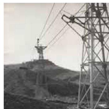
1960, impianti Montedison per l'estrazione del Salgemma, presso Cozzo Disi. In alto, una foto del paraboloidi (interno). Fondo Edison.
