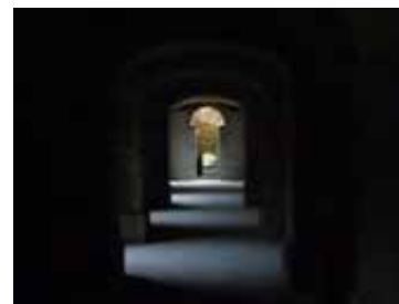
Palazzo Pennisi, foto dei sotterranei
