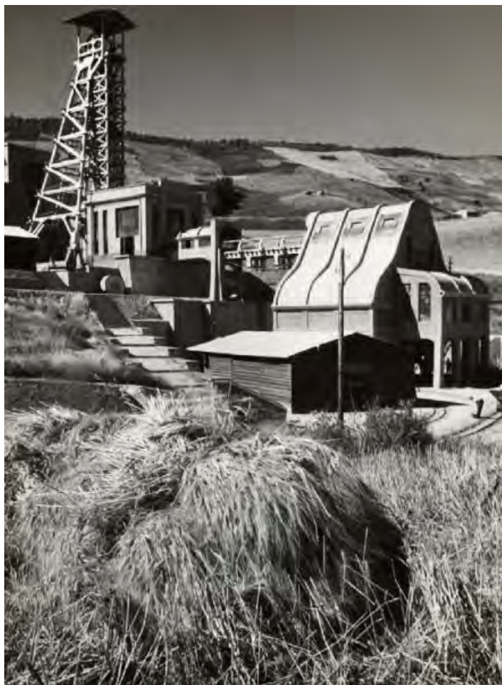
Grottafaldina. Veduta del pozzo Mezzena con il castello di estrazione e il silos di raccolta del minerale.
