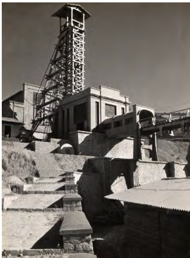
Grottafaldina. Veduta del pozzo Mezzena con il castello di estrazione e gli impianti adiacenti.
