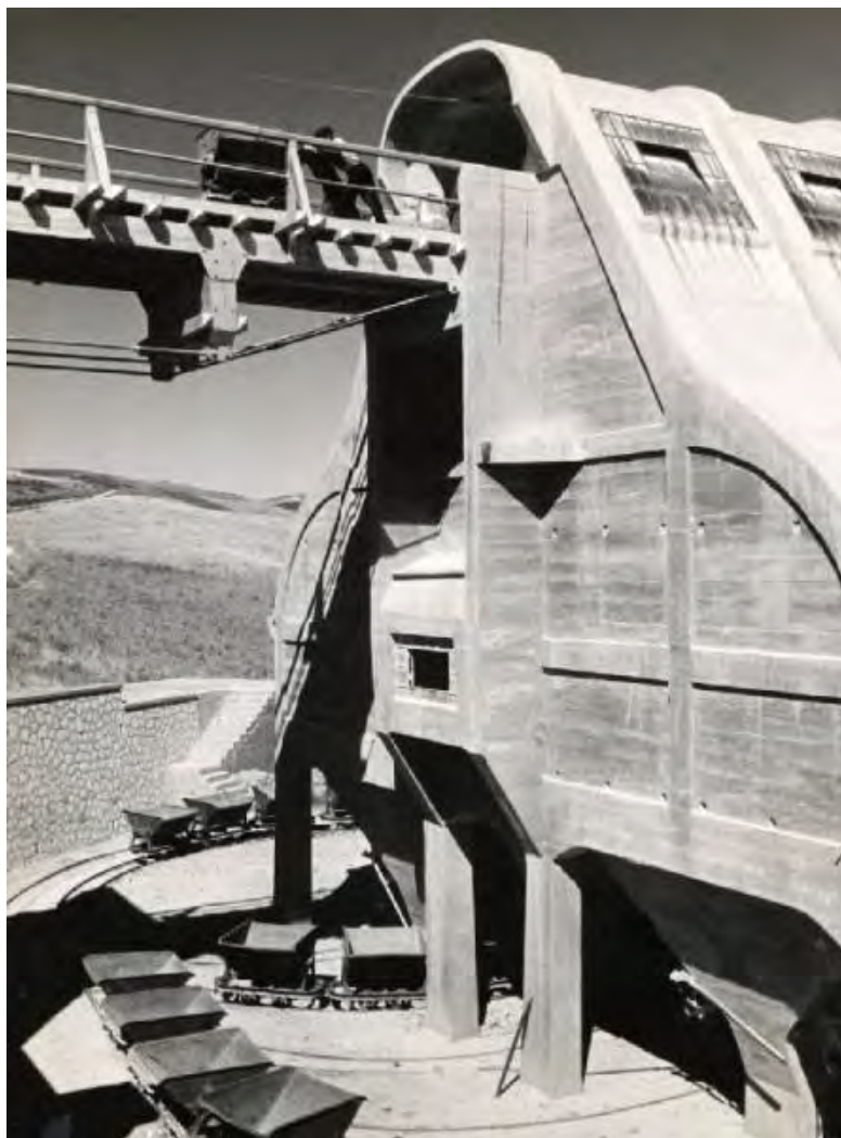
Grottafaldina. Veduta del pozzo Mezzena con il silos per la raccolta del minerale.
