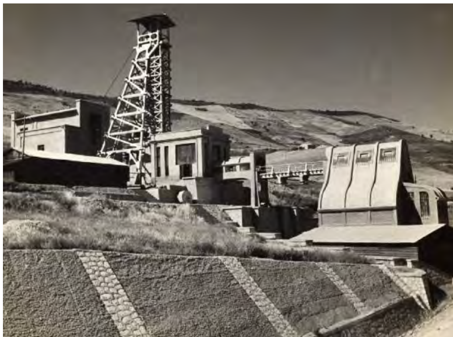
Grottafaldina. Veduta del pozzo Mezzena con il castello di estrazione e il silos di raccolta del minerale
