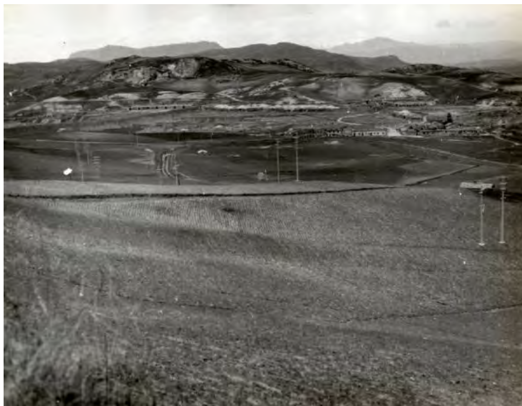
Grottafaldina. Veduta generale della miniera e degli impianti.
