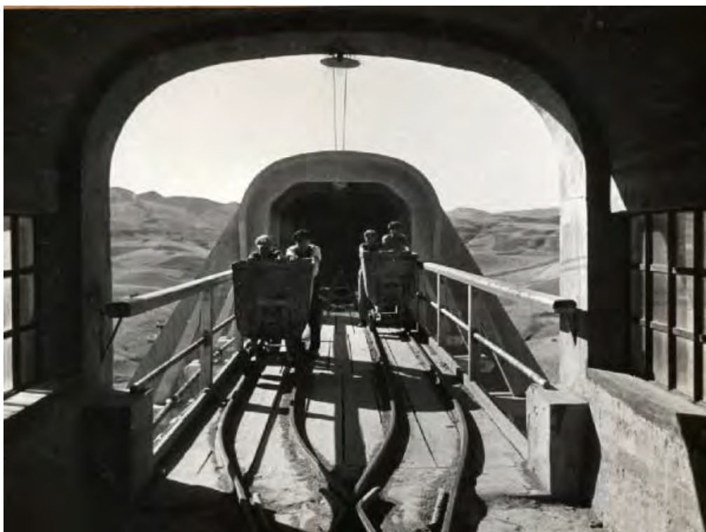
Grottaalda. Pozzo Mezzena: silos di raccolta dello zolfo estratto dalla miniera. Quattro minatori trasportano due vagoni fuori dal silos, verso il castello di estrazione.
