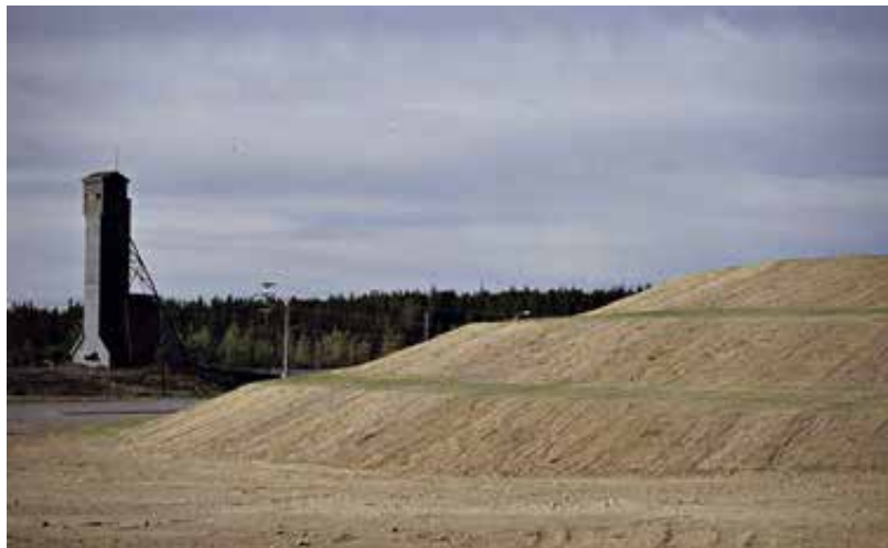
Vista di uno dei terrapieni e del castelletto di estrazione
