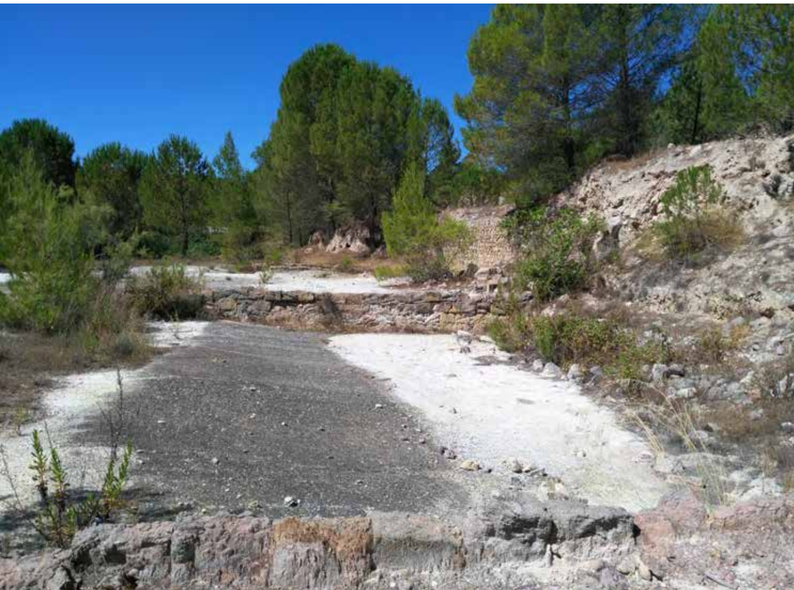
Piano inclinato di accesso ai calcheroni. Foto dell'autore.
