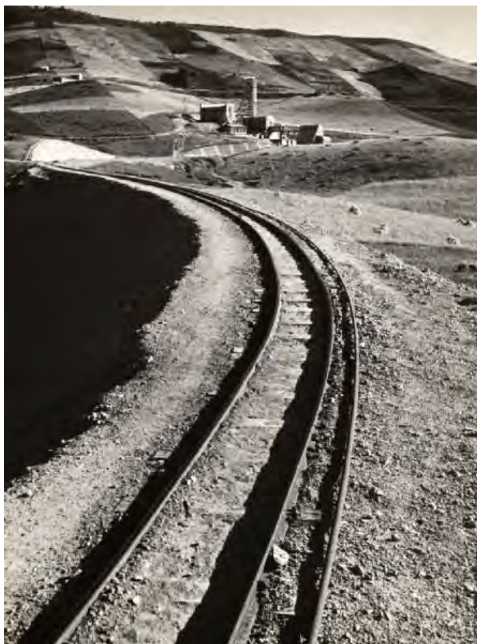
Grottafaldina. Veduta dei binari per il trasporto del minerale estratto. Sullo sfondo il pozzo Mezzena e gli impianti della miniera.
