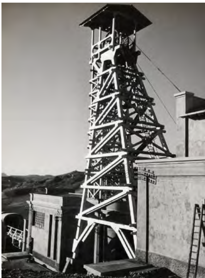
Grottafaldina. Veduta del pozzo Mezzena con il castello di estrazione.
