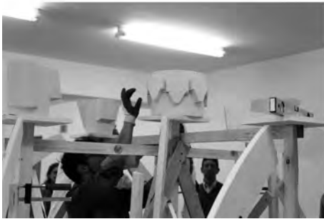
17. Realizzazione della piattaforma di lavoro e dei piedritti di sostegno delle chiavi.
