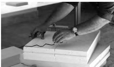
12. Sagome e tracciamento dei filari del tas-de-charge .
