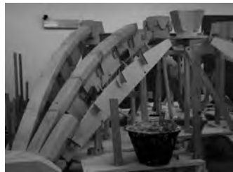
18-20. A sinistra, fissaggio dei piedritti di sostegno e posa in opera delle centine degli archi; al centro, posa in opera dei primi concetti dei costoloni; a destra, posa in opera delle vele.
