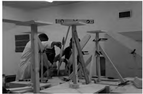
17. Realizzazione della piattaforma di lavoro e dei piedritti di sostegno delle chiavi.
