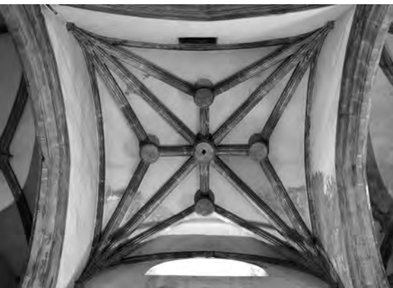
7. Palermo. Chiesa di Santa Maria di Portosalvo, intradosso della volta a cinque chiavi sulla crociera.
