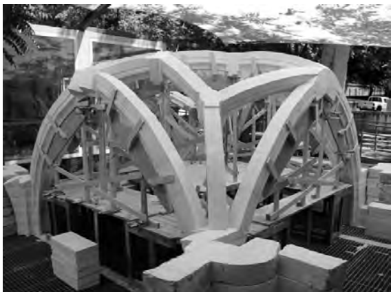
7. Modello riprodotto una volta sferica con nervature a rete dal trattato di Joseph Ribes.
