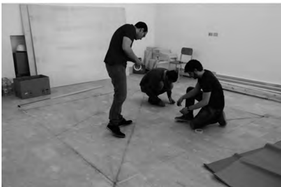
4. Tracciamento della pianta e dell'alzato della volta a grandezza naturale.
