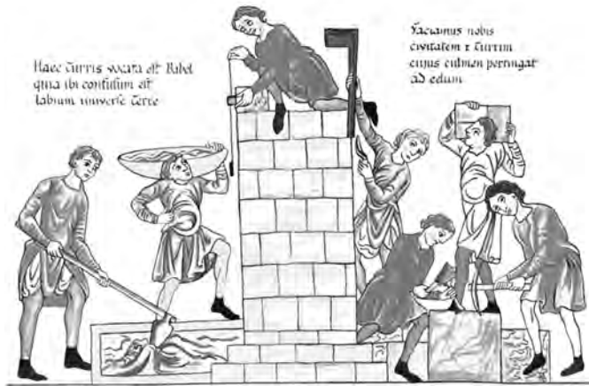
7. Il cantiere gotico, in una miniatura del tempo; lavori di muratura ed attrezzi del faber murarius .
