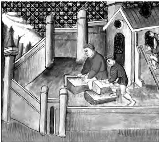
3. La costruzione dell'abbazia di St. Denis, in una raffigurazione medievale; fase di squadratura dei conci ( www.pierres-info.fr ).
