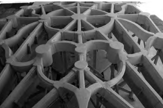
3. Modello della volta a crociera piana del sotto-coro del convento di San Esteban a Salamanca, opera di Juan de Álava.
