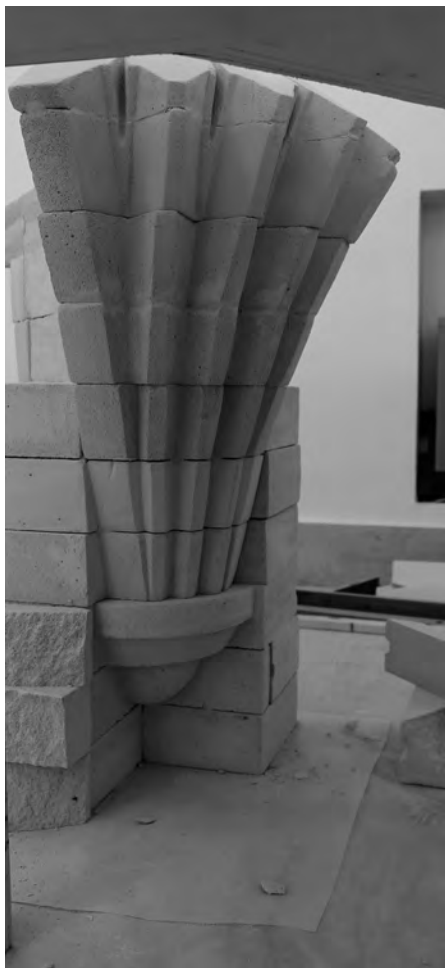
16. Posa in opera del tas-de-charge .
