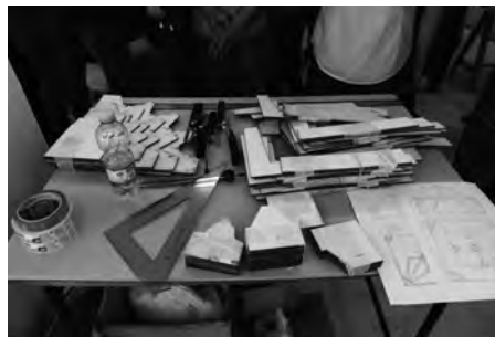
6. Baibel e sagome per il taglio degli elementi della volta.
