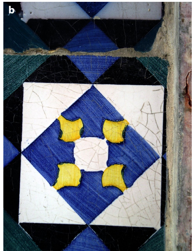
Figura 5. Aplicação agregada de réplicas de restauro e pormenor de um desses novos azulejos (Travessa do Fala-Só, Lisboa). Imagens: A.Chaban, 2014.
