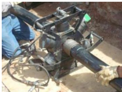
Рис.6. Монтаж гидравлической муфты
