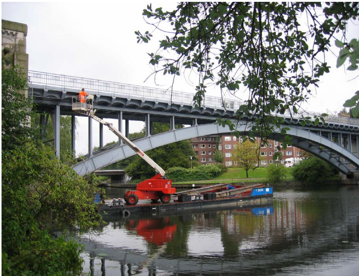
Abbildung 5: Brückenprüfung mit Steiger auf einem Hamburger Fleet.
