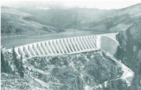
Figura 7. **Ejemplo de presa de contrafuerte.**
