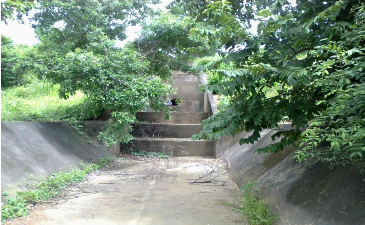
Figura 21. Vista de alcantarilla y dissipador de energía.
