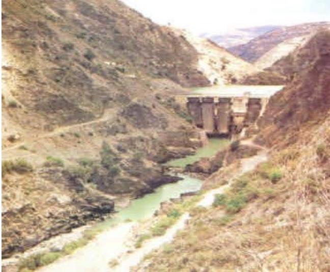
Figura 6. **Ejemplo de presa en arco**
