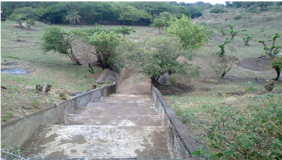
Figura 20. Disipador en gradas con su respectivo canal.
