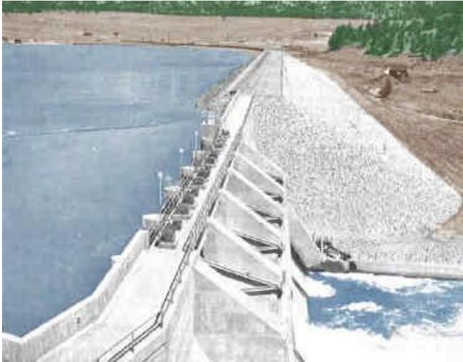
Figura 5. **Ejemplo de presa combinada.**
