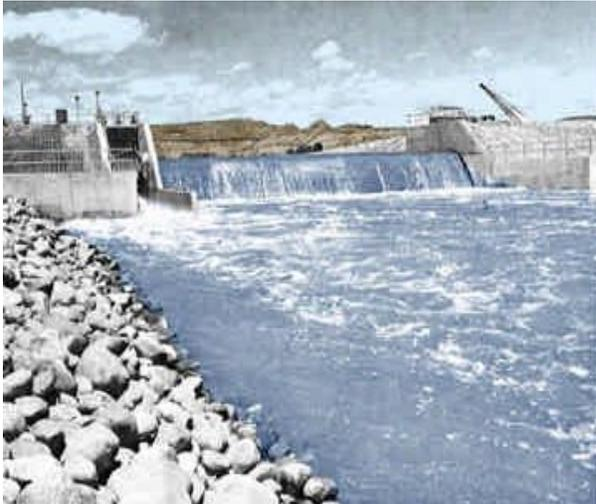
Figura 2. **Ejemplo de presa de derivación**
