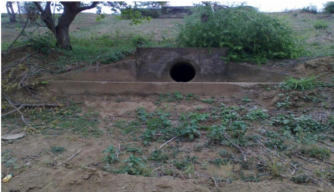
Figura 18. Mejor apreciación de alcantarilla con diámetro 60 cm.
