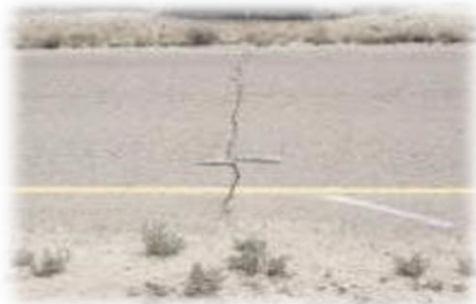
Figura 3. Fallas por susceptibilidad térmica
