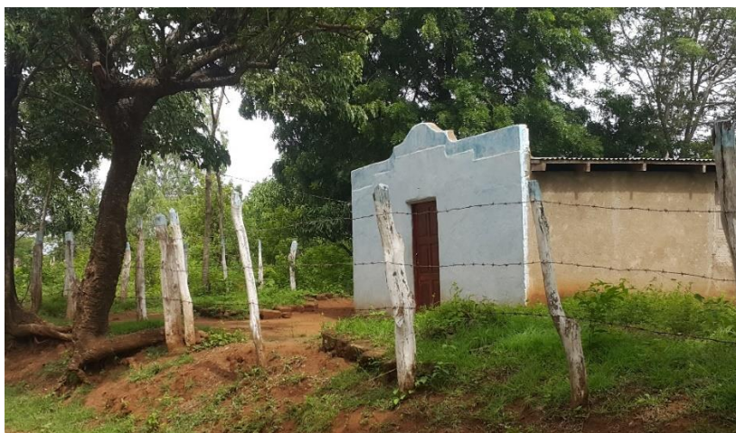
Ilustración 18: Iglesia de la comunidad Paso real.
