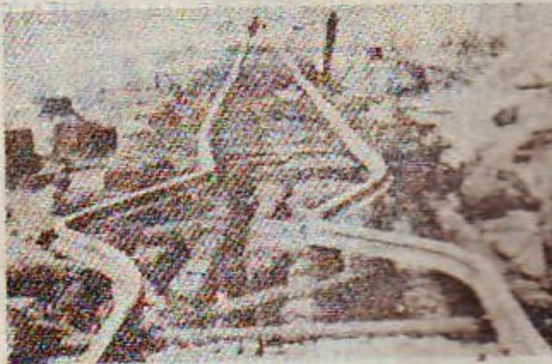
FIGURA 1-13. El enorme aumento de temperatura producido durante un incendio, puede provocar una gran deformación en los rieles de una vía férrea, a pesar de la existencia de las juntas de dilatación.
