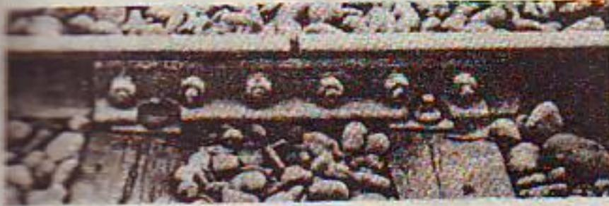
FIGURA 1-11. Junta de dilatación entre los rieles de una vía de ferrocarril.
