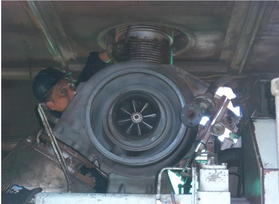
Anexos 10: Desmontaje de un Turbocompresor.
