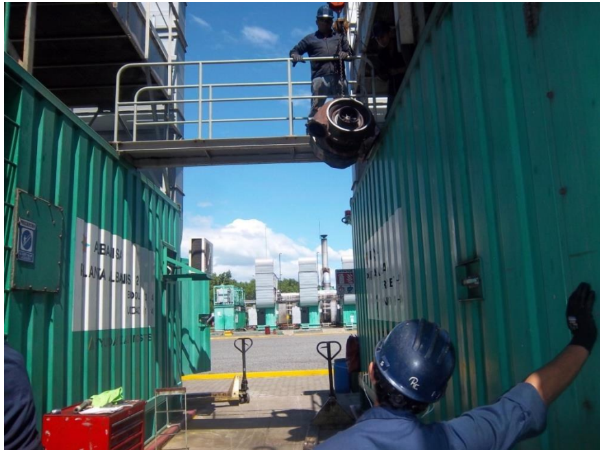
Anexos 11: Extracción de Turbocompresor del MDU.
