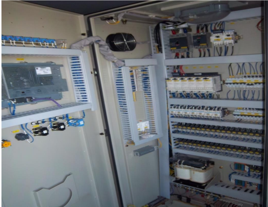
Anexos 8: Reparación de los Paneles de Control.
