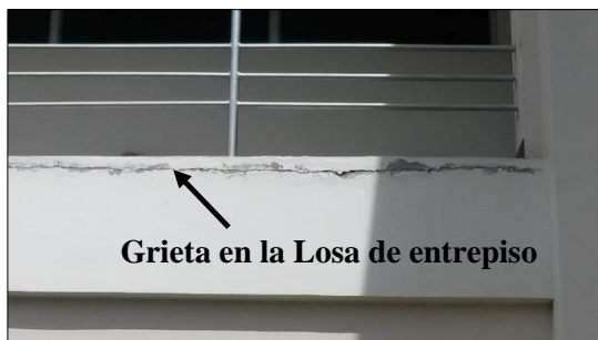
Figura 1.2. (a) Grieta en la unión de la losa de entrepiso con la viga de entrepiso; (b) Grieta en el muro de corte ubicado en el costado Sur del edificio. Fuente: Autores.
