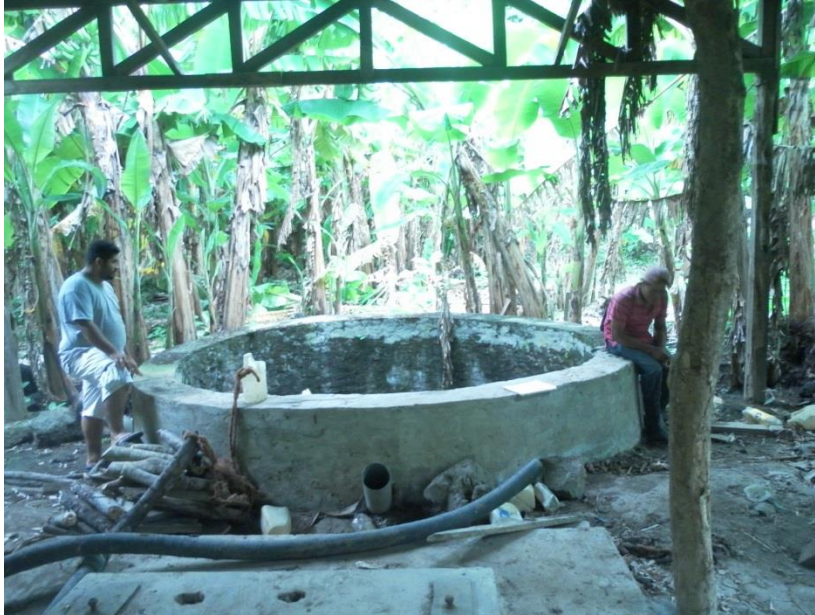
Pozo donde se extraerá el agua para el sistema de fertiriego
