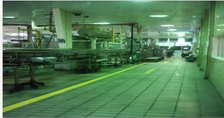
Figura 1: Pasillo línea vidrio
