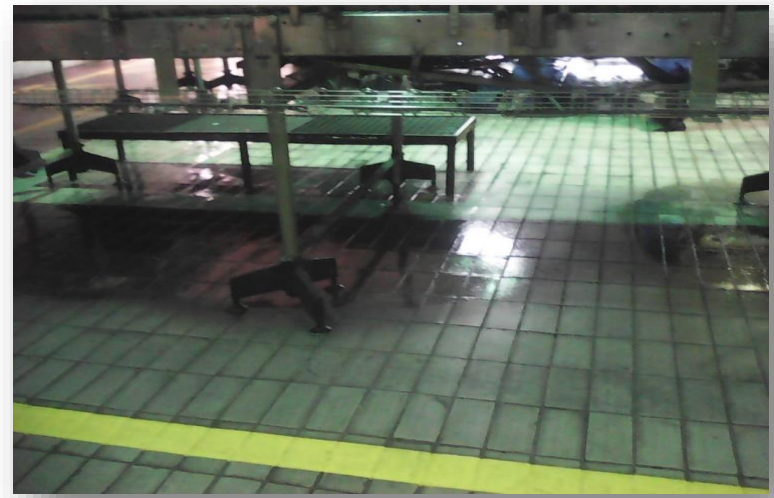
Figura 3: Banda transportadora línea vidrio
