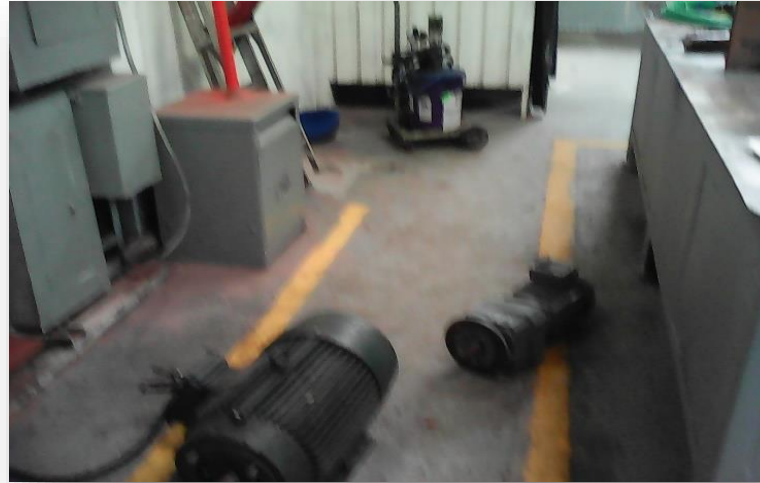
Figura 1. Pasillo taller de mantenimiento
