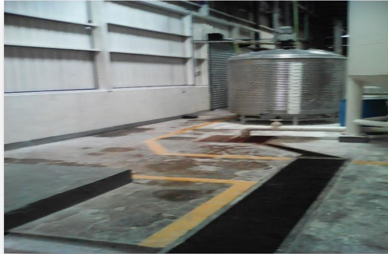
Figura 1. Mezcladora tratamiento de aguas
