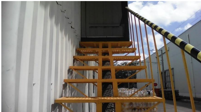
Figura 2. Escaleras hacia oficina de soplado
