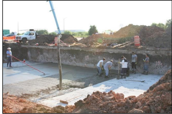
(b) Slab-on-Grade Pour
