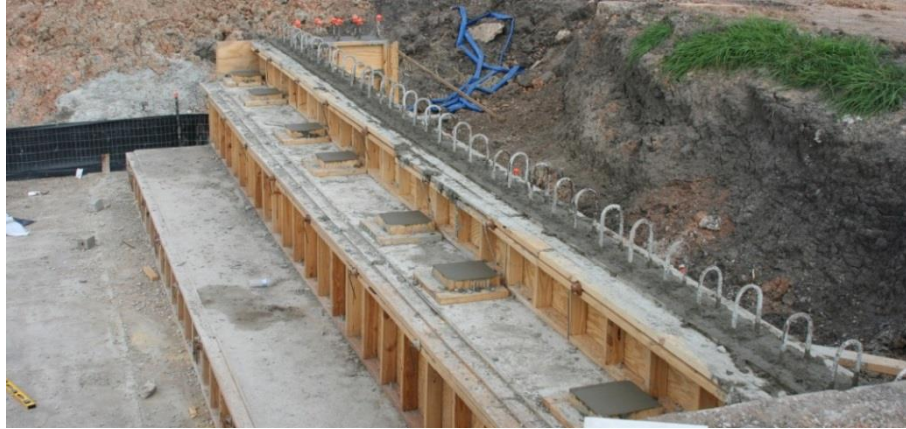
(a) Back-Wall, Pedestal, and Wing-Wall Pour
