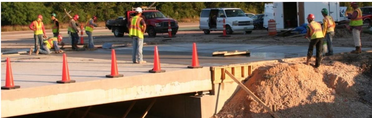
(d) Approach Slab Broom Finish
