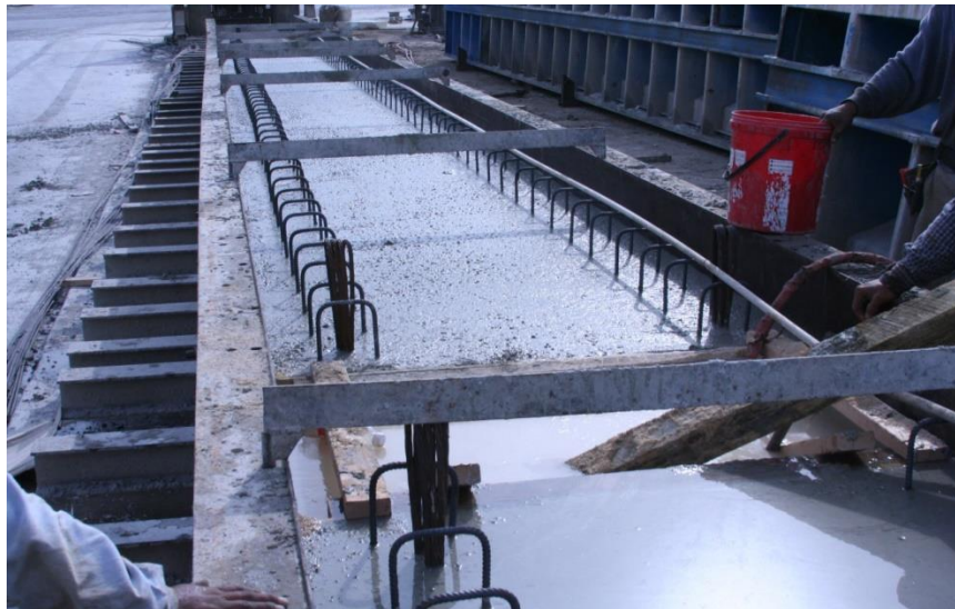
(c) Slab Beam Pour
