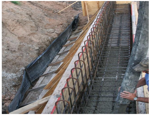
(d) Abutment Concrete Pour
