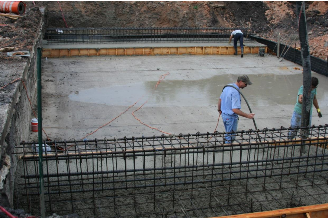
(b) Footing Concrete Pour
