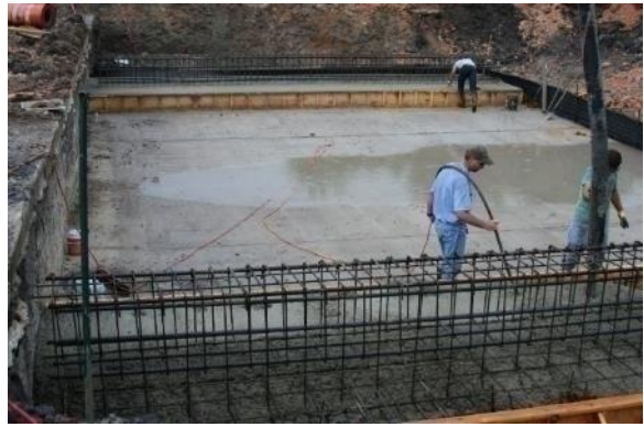
(b) Footing Concrete Pour
