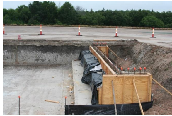
(b) Abutment Concrete Pour
