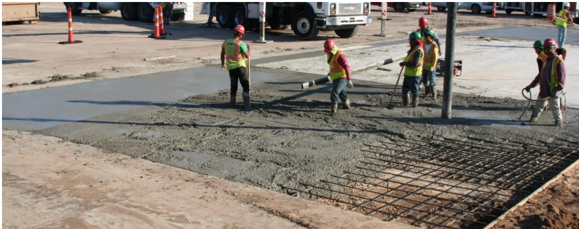
(b) Approach Slab Concrete Pour
