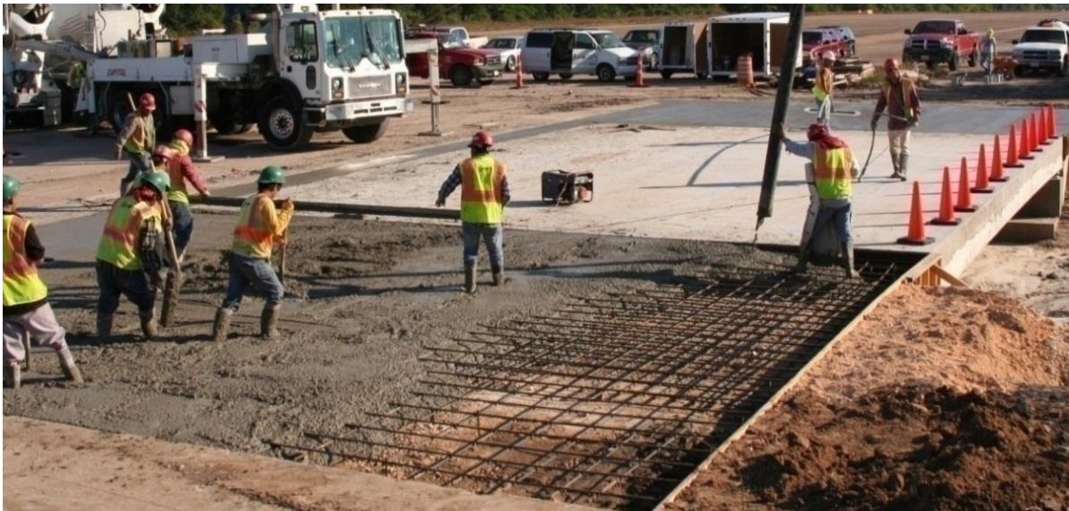
(c) Approach Slab Pour
