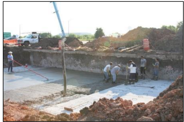
(b) Slab-on-Grade Pour
