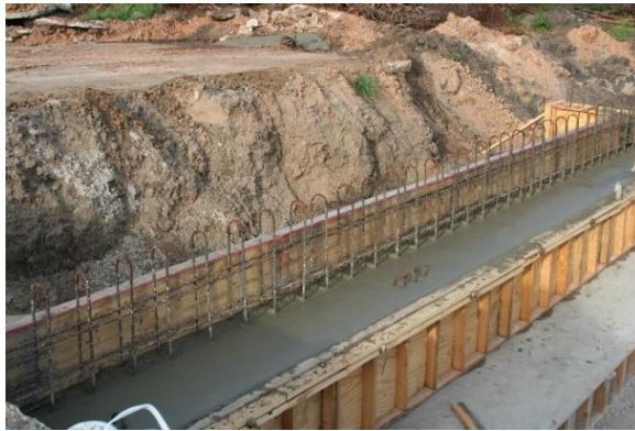
(b) Abutment Concrete Pour
