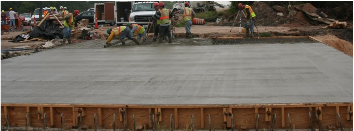
(c) Deck Concrete Pour
