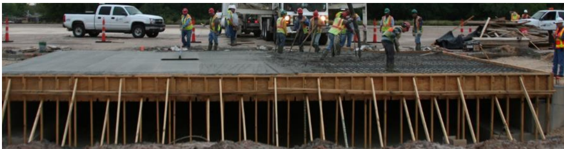
(b) Deck Concrete Pour
