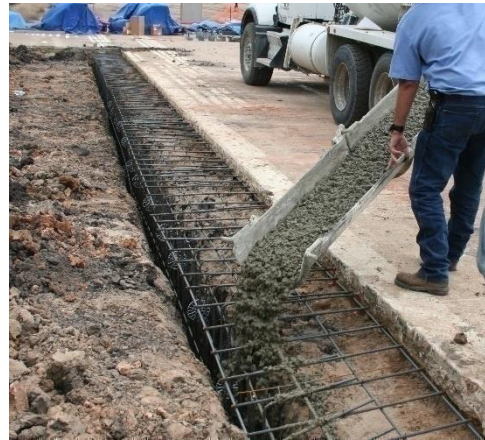
(b) Retaining Wall Concrete Pour
