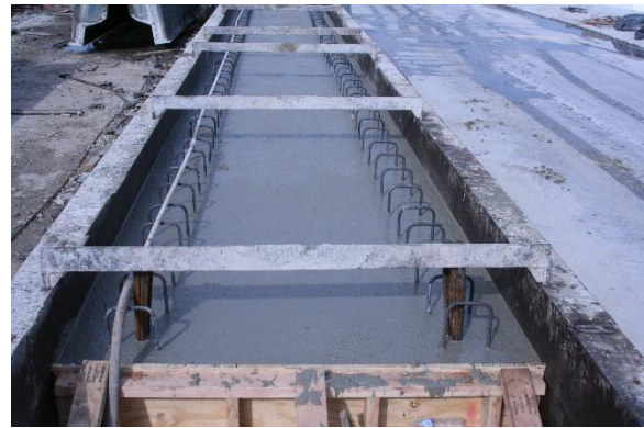
(b) Slab Beam Concrete Pour
