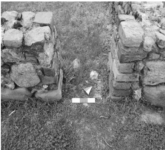
Immagine 63: TINDARI, INSULA IV, CASA C, INGRESSO N-E VANO 13
