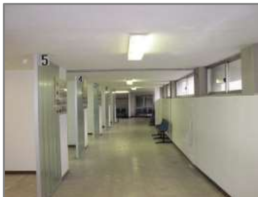
Figura 2.17: Piano seminterrato, si notano a destra i pilastri non completamente tamponati
