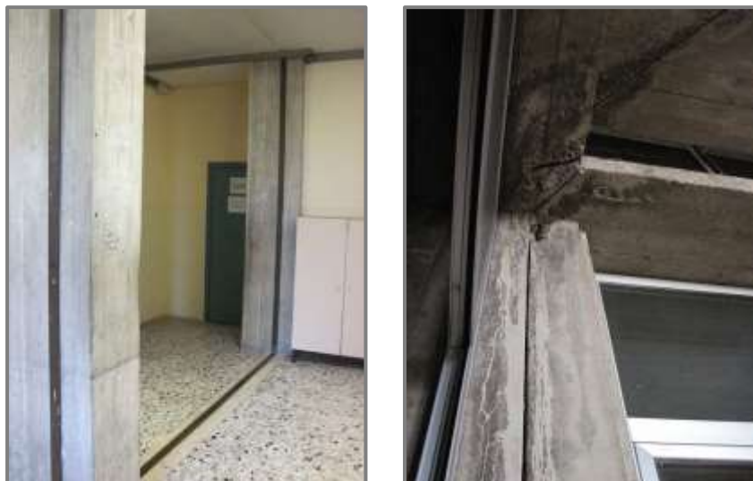
Figura 2.15: Giunto tecnico che separa l'edificio B in due parti. Visione dall'interno della struttura (sinistra) e dall'esterno (destra)
