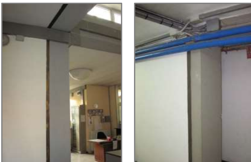
Figura 2.14: Giunto tecnico che separa l'edificio B dagli edifici adiacenti Giunto tecnico al piano terra (sinistra), giunto tecnico al piano seminterrato (destra)
