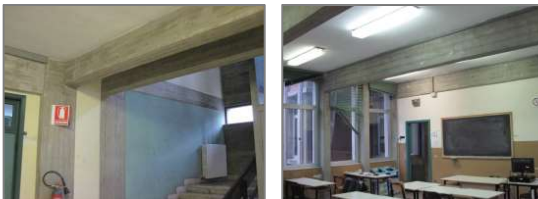
Figura 2.19: Travi ricalate al piano primo, travi del vano scala (a sinistra), travi in un'aula (a destra)
