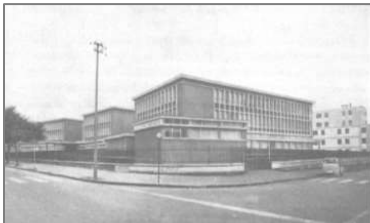
Figura 2.3: Il complesso dell'Istituto tecnico a lavori ultimati
