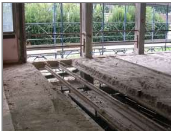
Figura 2.23: Travetti del solaio messi a nudo nell'Edificio A
