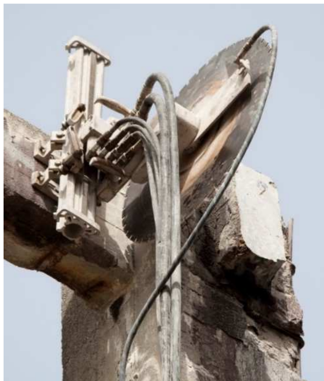
Figura 3.5 – Trave tagliata mediante sega a muro
