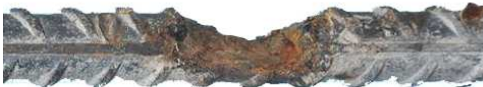
Figura 2.4 – Corrosione per pitting
