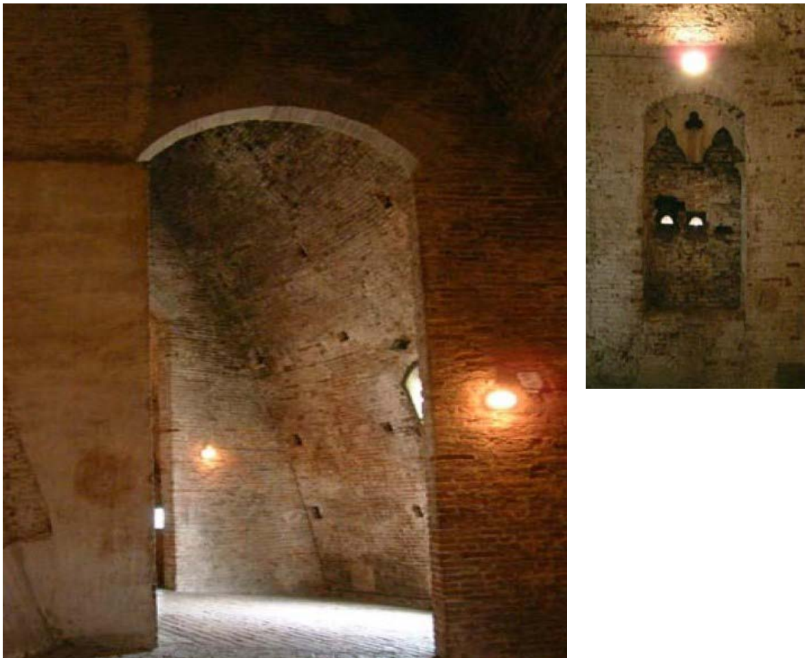
Fig. 19: Setto che divide la galleria tra le due cupole e finestra tamponata nel sottovolta
