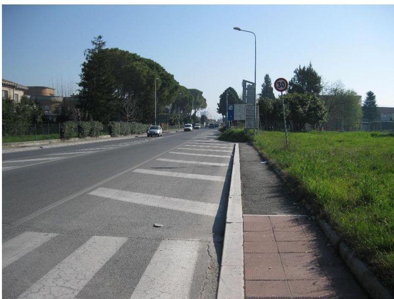
Figura 30 La via Flaminia in corrispondenza della Caserma dei Carabinieri (direzione Terni).
