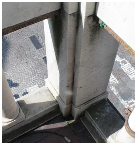
Questa armatura metallica in ferro si mostra oggi particolarmente danneggiata dall'esposizione agli agenti atmosferici e deve essere sostituita in modo da realizzare un consolidamento strutturale di tutto il balcone.
