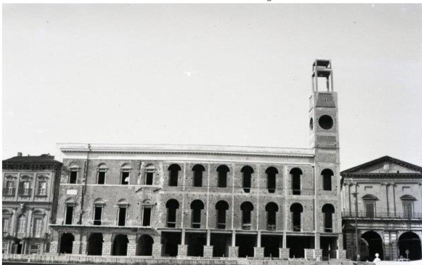
4.12 Foto del prospetto nord del Pretorio durante la ricostruzione avvenuta tra il 1953 e il 1958. Si può chiaramente vedere come il nuovo palazzo si ricuce alla parte superstite a sinistra con una struttura in cemento armato.
