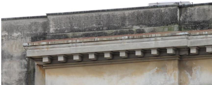
Si tratta di un muretto in cemento armato intonacato posto a protezione del canale di gronda, che oggi si presenta particolarmente deteriorato. Si sono
