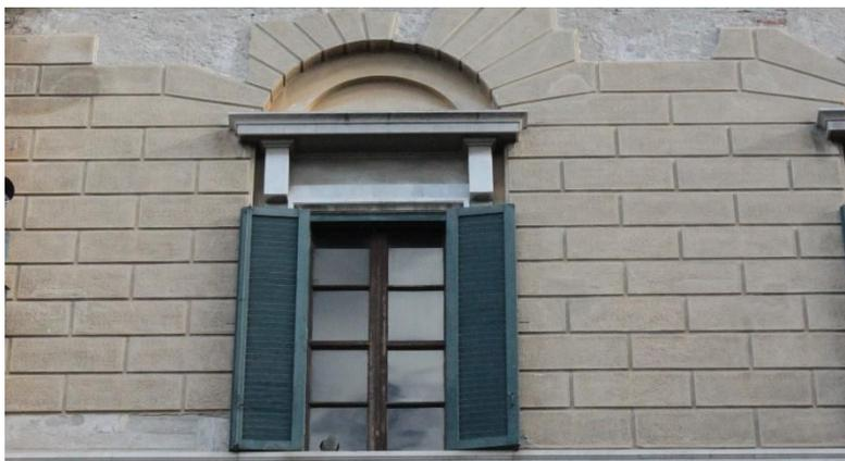
L'intonaco con cui è stato realizzato il finto bugnato per gran parte della facciata presenta diverse tipologie di degrado che vanno dalla patina dovuta allo sporco che con il tempo si è insinuato nelle cavità, all'efflorescenza dovuta alla
