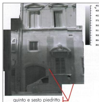
Figura III-19 - Rilievo termografico del quarto piedritto a piano terra dall'esterno dell'edificio.
