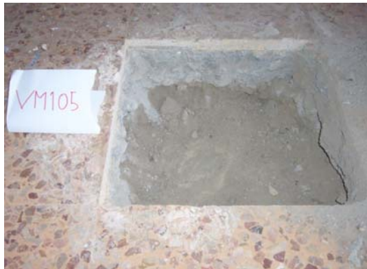
Figura 2.4-39: Saggio sui solai 1-05
