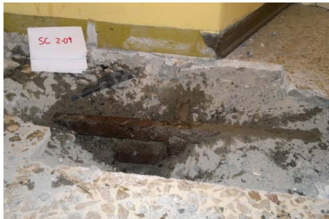
Figura 2.4-45: capichave di catene a sezione quadrilatera
