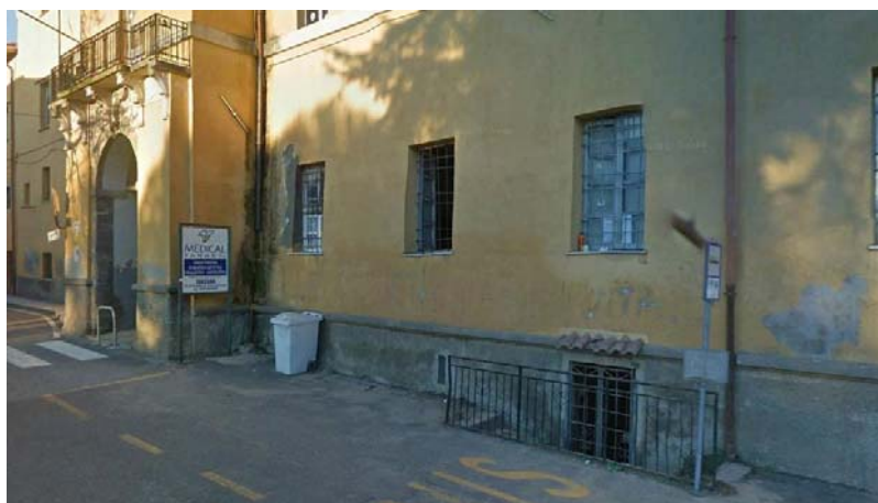
Figura 2.2-3: Accesso piano sotto-strada
