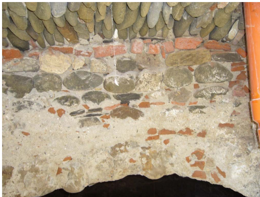
Figura 2.4-26: Strati di pietra di fiume nelle volte
