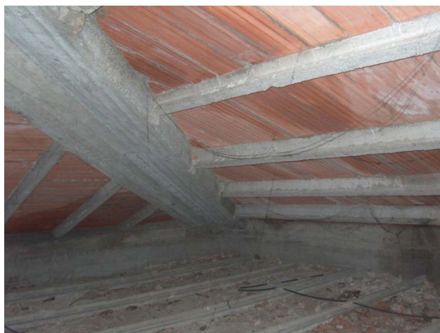
Figura 2.2-10: Foto copertura sottotetto
