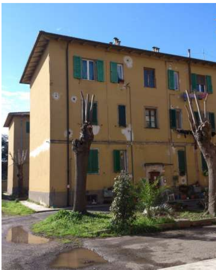
Figura 1.11 Spazio a verde di “arredo” antistante un edificio situato al limite meridionale del lotto
