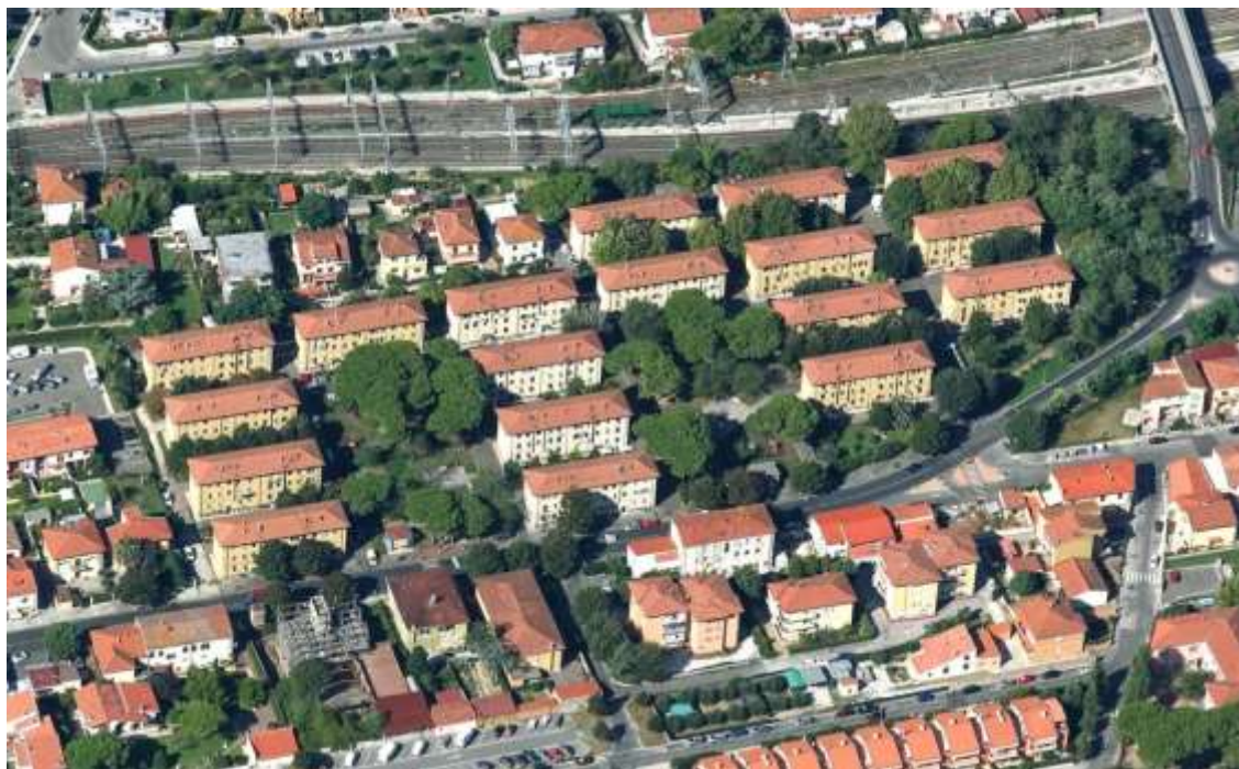
Figura 1.5 Vista dall'alto del complesso di edilizia sociale del 1947 in Sant'Ermete
