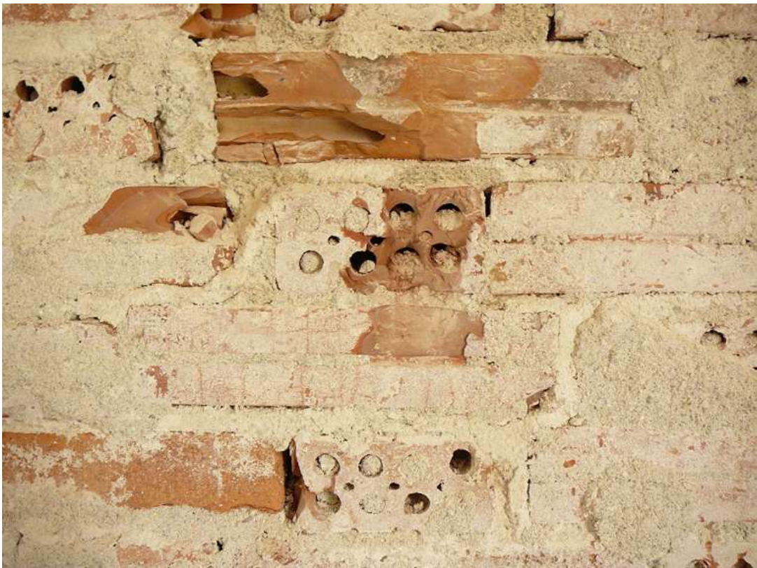
Figura 2.8 Particolare della muratura in mattoni a fori orizzontali vista dall'interno dell'appartamento gestito da APES
