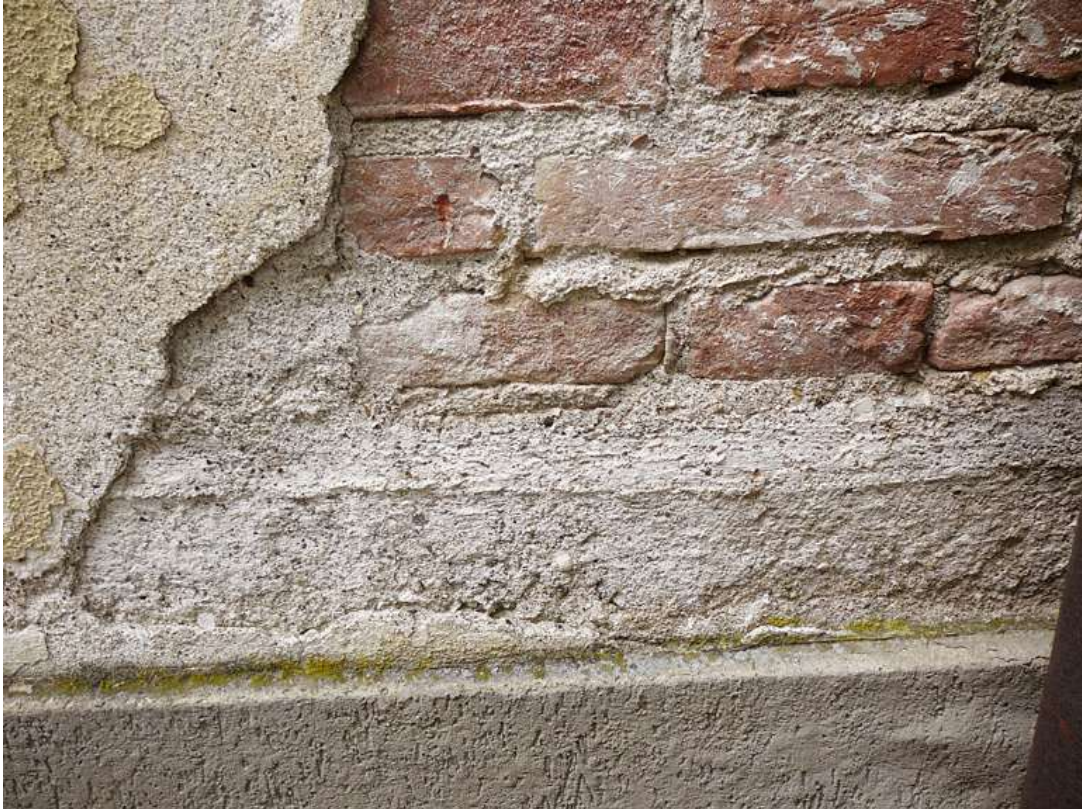
Figura 2.7 Particolare esterno della tessitura muraria alla base dell'edificio
