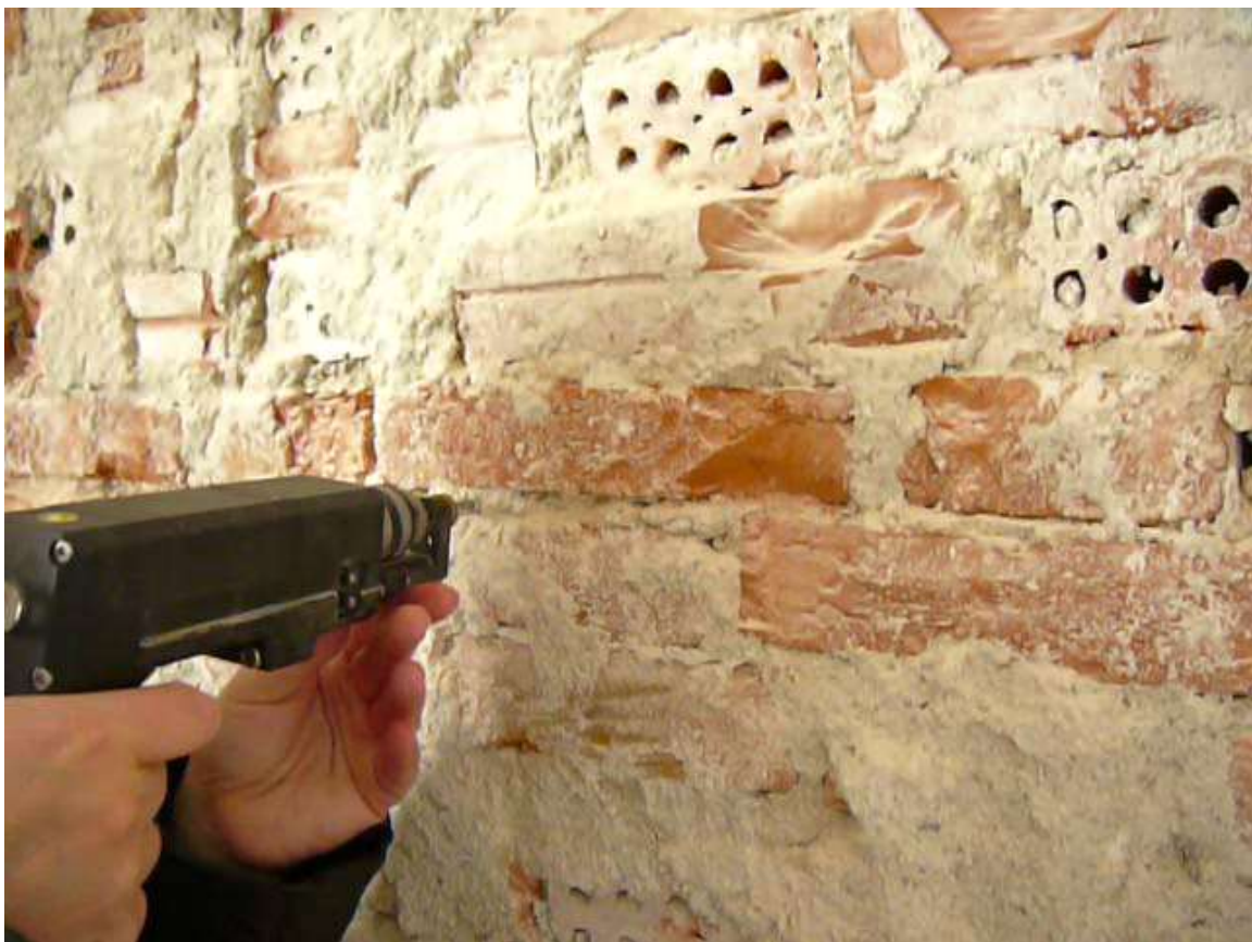
Figura 3.6 La prova con il penetrometro PNT-G su una parete interna
