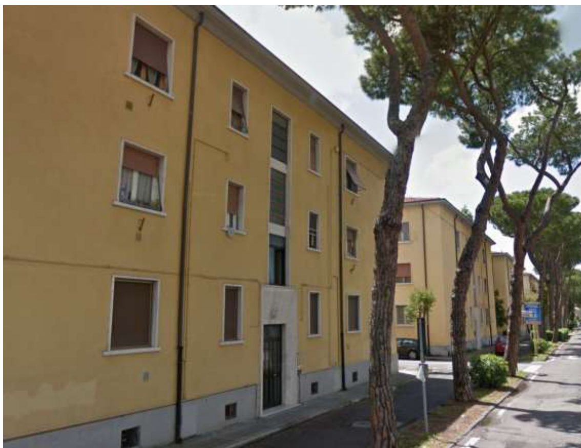
Figura 1.1 Vista del complesso di via Ugo Rindi del 1945
