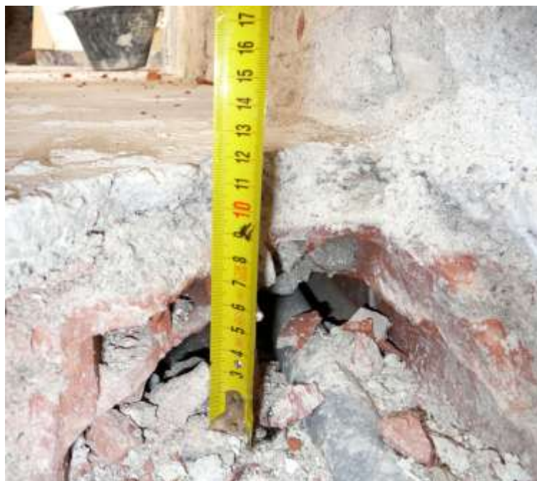
Figura 5.1 Indagini parzialmente distruttive del solaio per la verifica dello spessore
