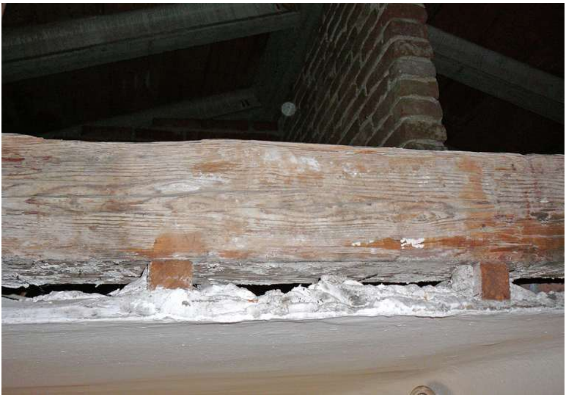
Figura 2.10 Particolare del controsoffitto incannucciato
