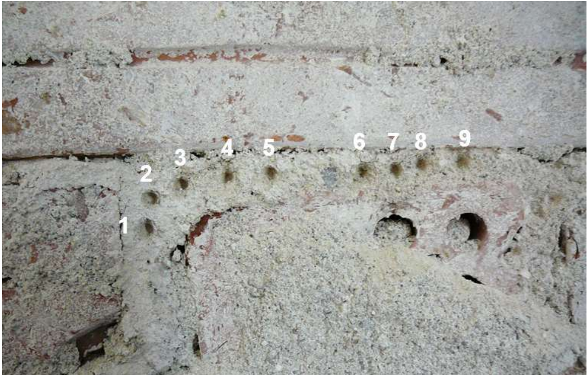
Figura 3.5 Sondaggi effettuati su un giunto di malta
