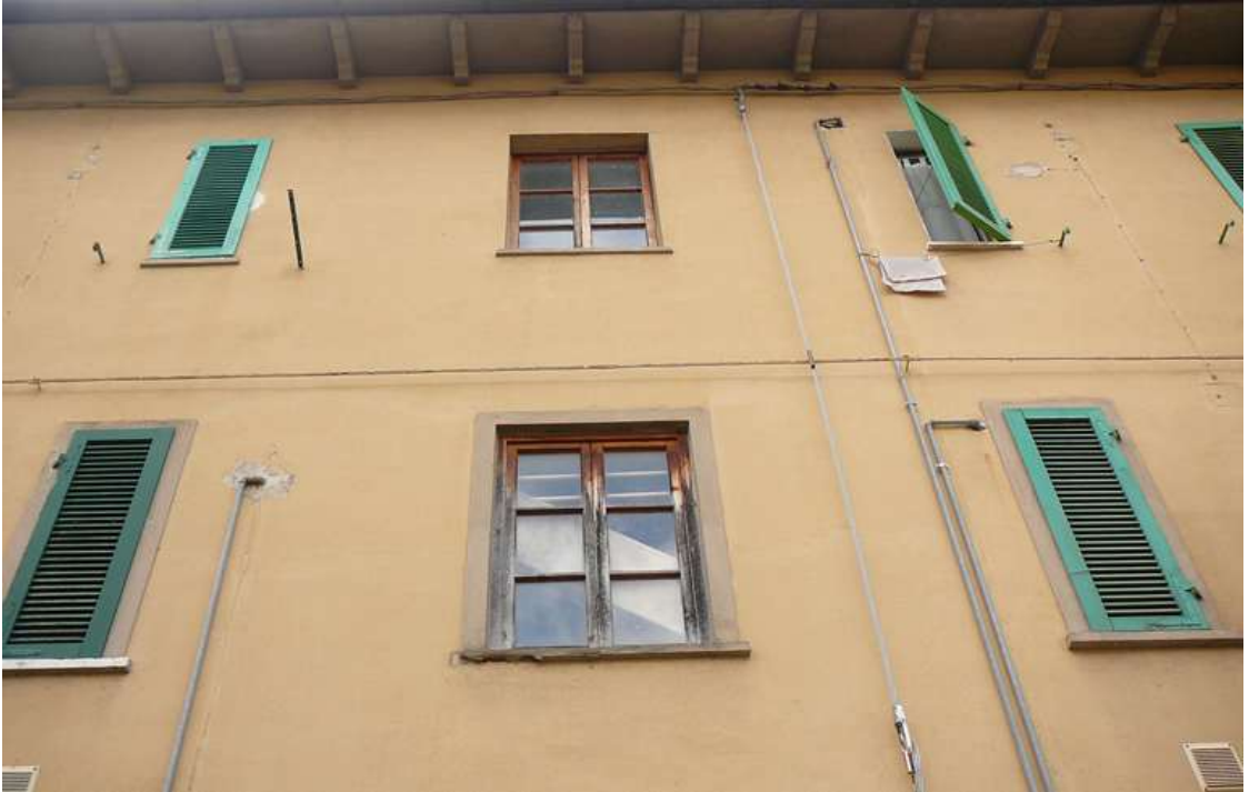
Figura 2.2 Particolare della facciata principale dell'edificio di via Bronzetti
