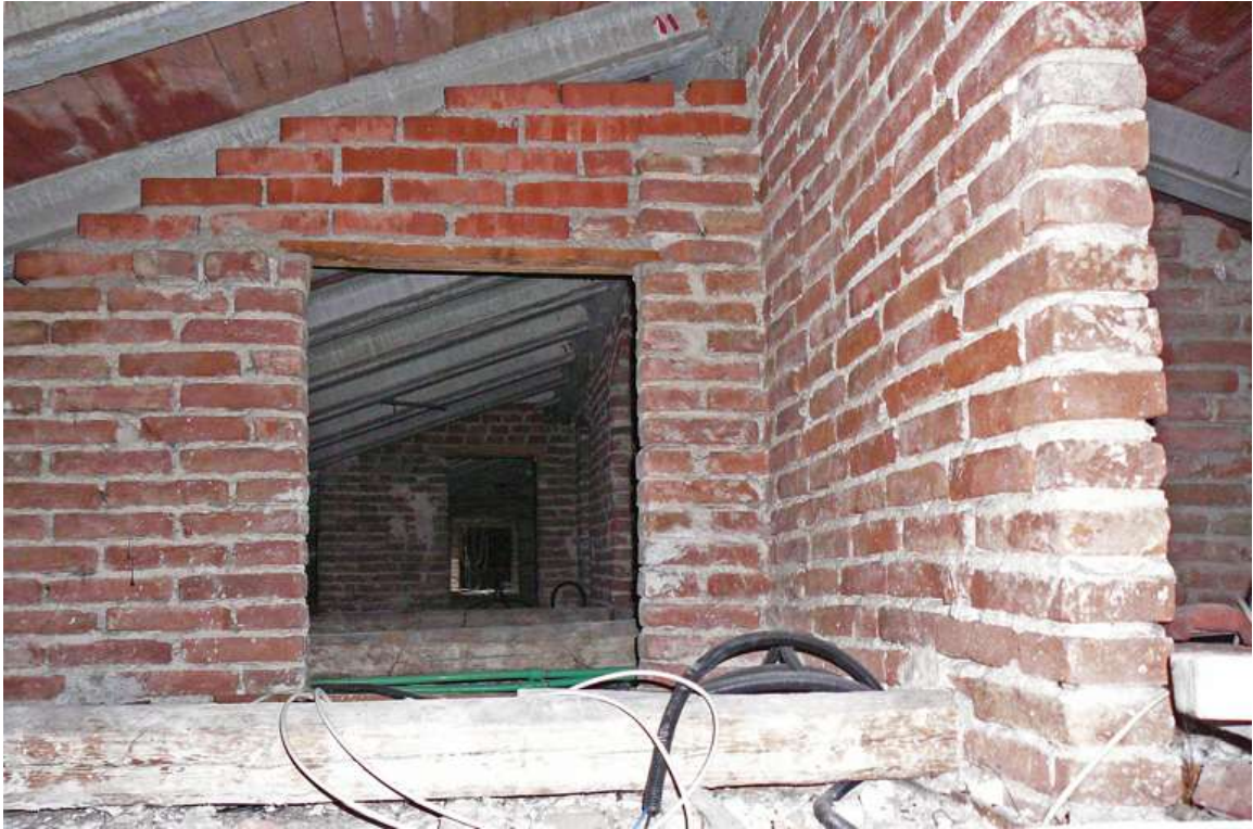
Figura 2.9 Il sottotetto dell'edificio di via Bronzetti
