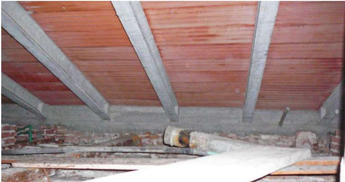
Figura 5.2 Interasse dei travetti Varese della copertura
