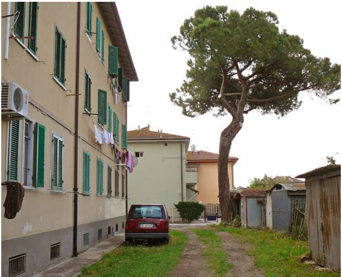
Figura 2.3 Vista posteriore dell'edificio di via Bronzetti
