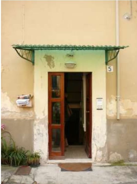
Figura 2.4 Un ingresso dell'edificio
