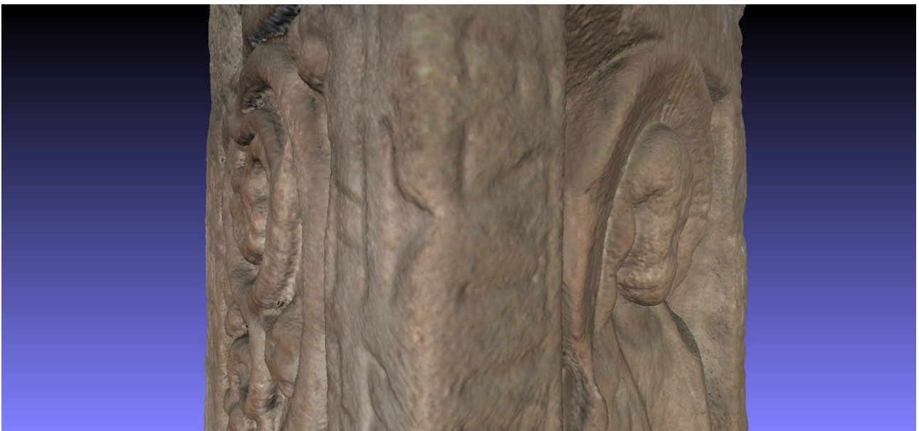
Figura 26 – Dettaglio della seconda della terza riga della colonna di nord-est, comprendente lato attiguo
